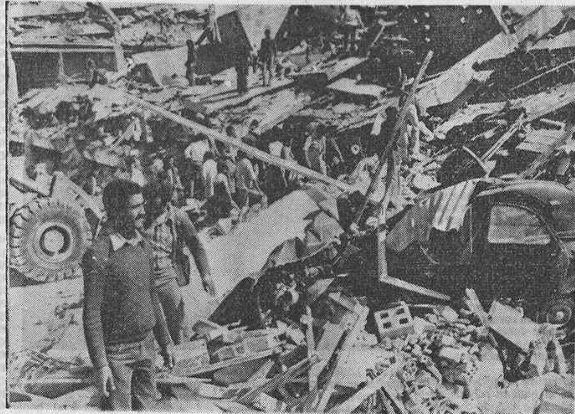
Al Asnam (Argelia). — Equipos de rescate proceden a la búsqueda de víctimas entre las montañas de escombros a que ha quedado prácticamente reducida la ciudad de Al Asnam, tras la sacudida sísmica registrada el pasado día 10. Millares de personas han resultado muertas. — (Teléfono EFE-AP)
