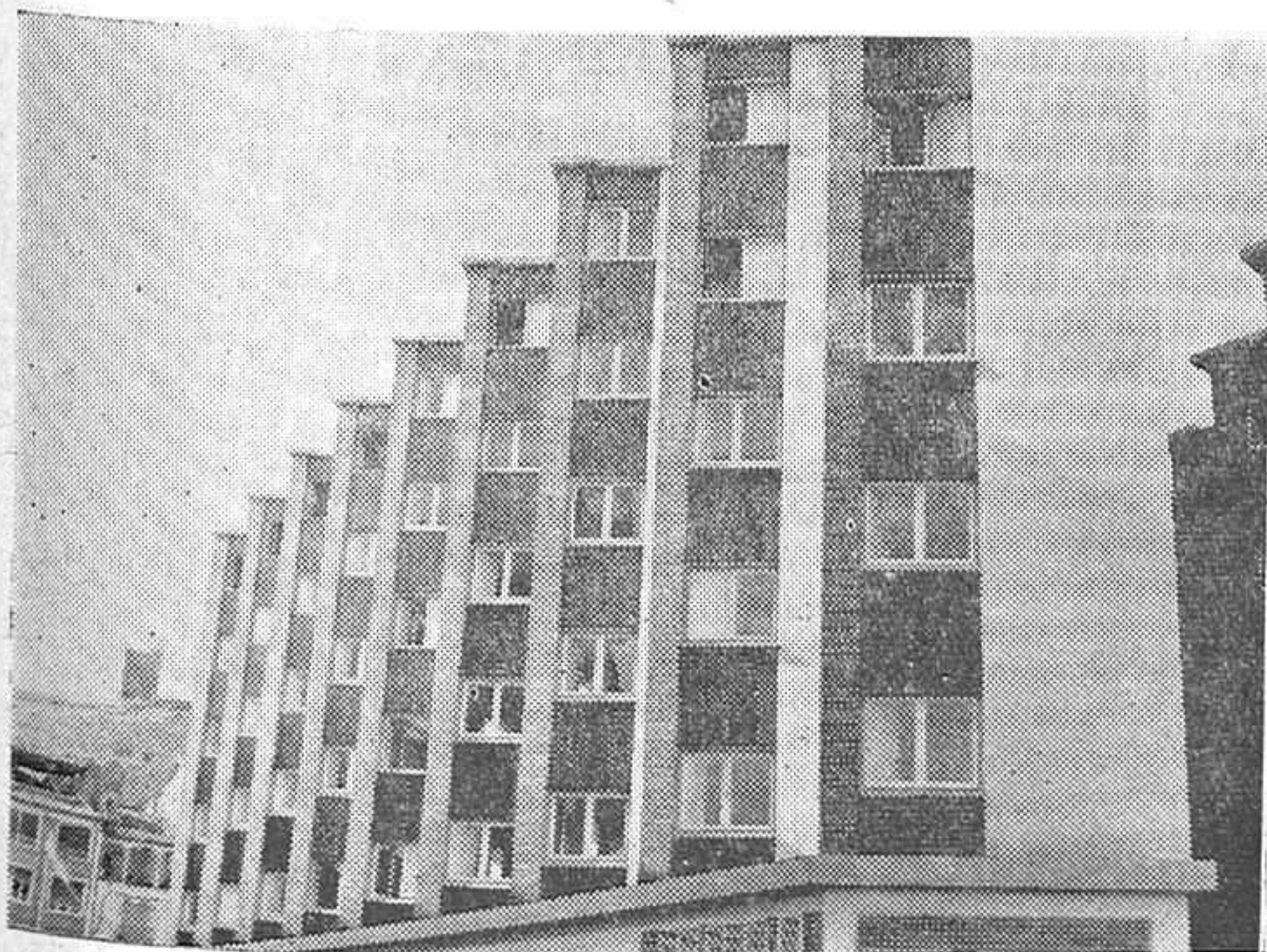
Viviendas en Molina de Aragón. —Dos importantes grupos de viviendas se han construido en Molina de Aragón, un ejemplo más de que la Caja atiende las solicitudes que se presentan para estas atenciones esenciales.
