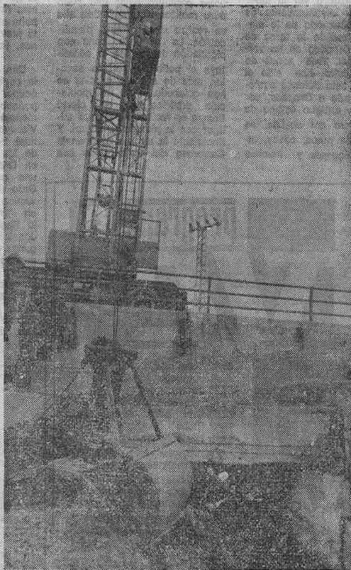
Obreros y maquinaria trabajando para limpiar la obstrucción del colector
