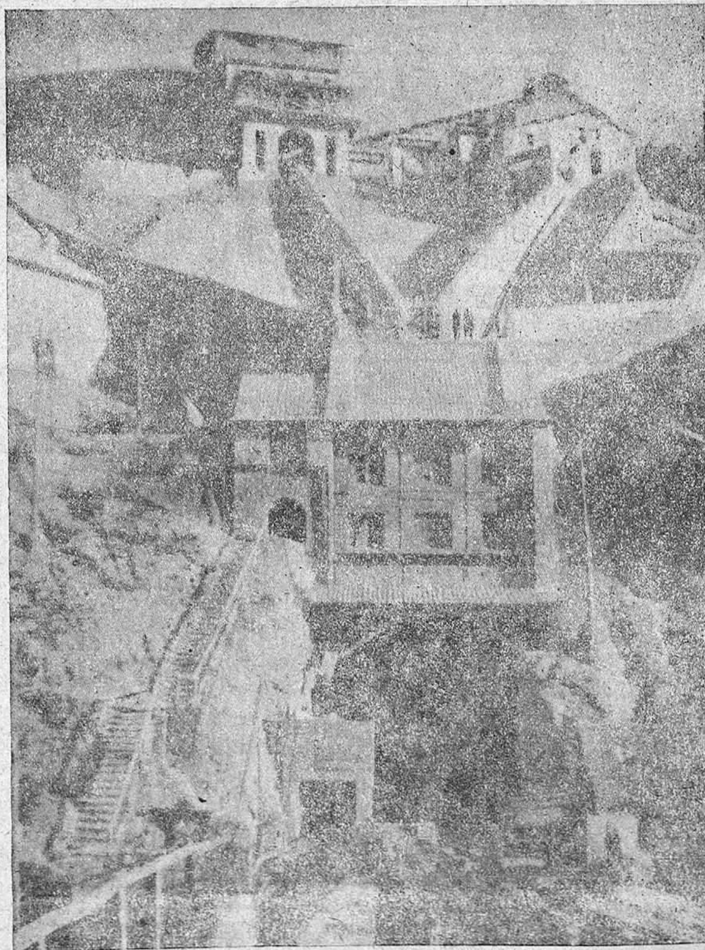
Vista parcial de la instalación de ma chaqueo y fabricación de hormigón en las obras del pantano de Entrepeñas.
