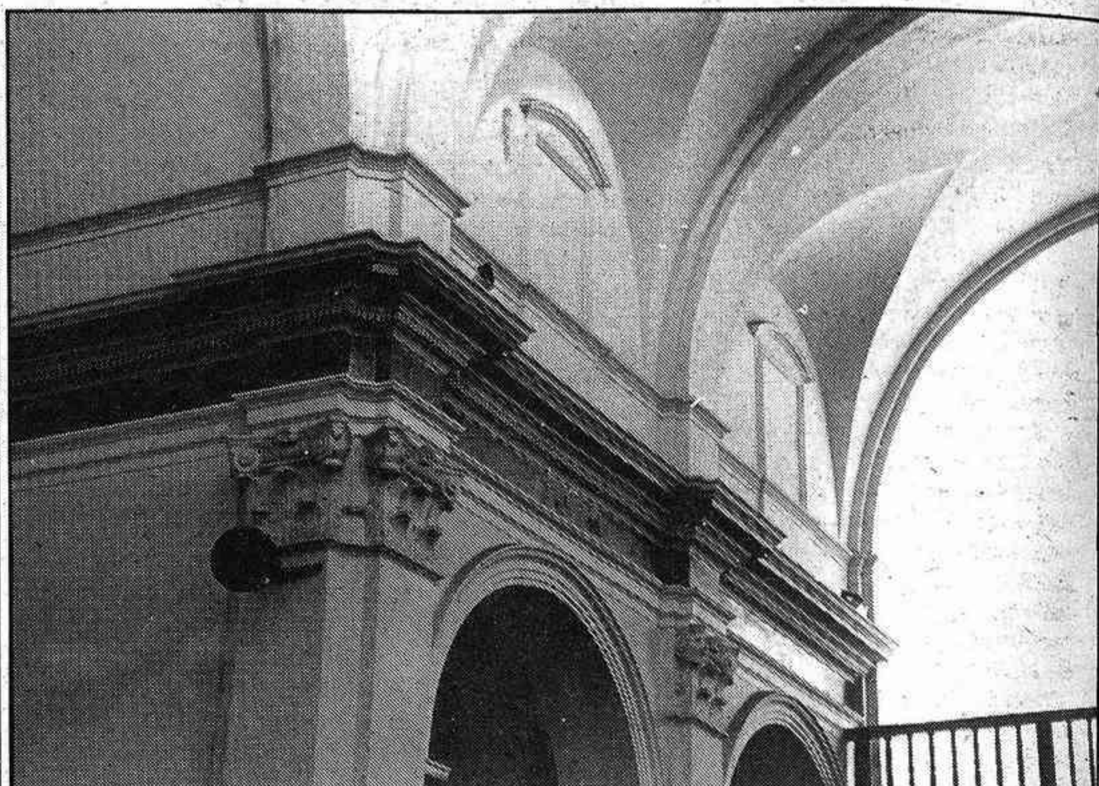
Arranque de las bóvedas
