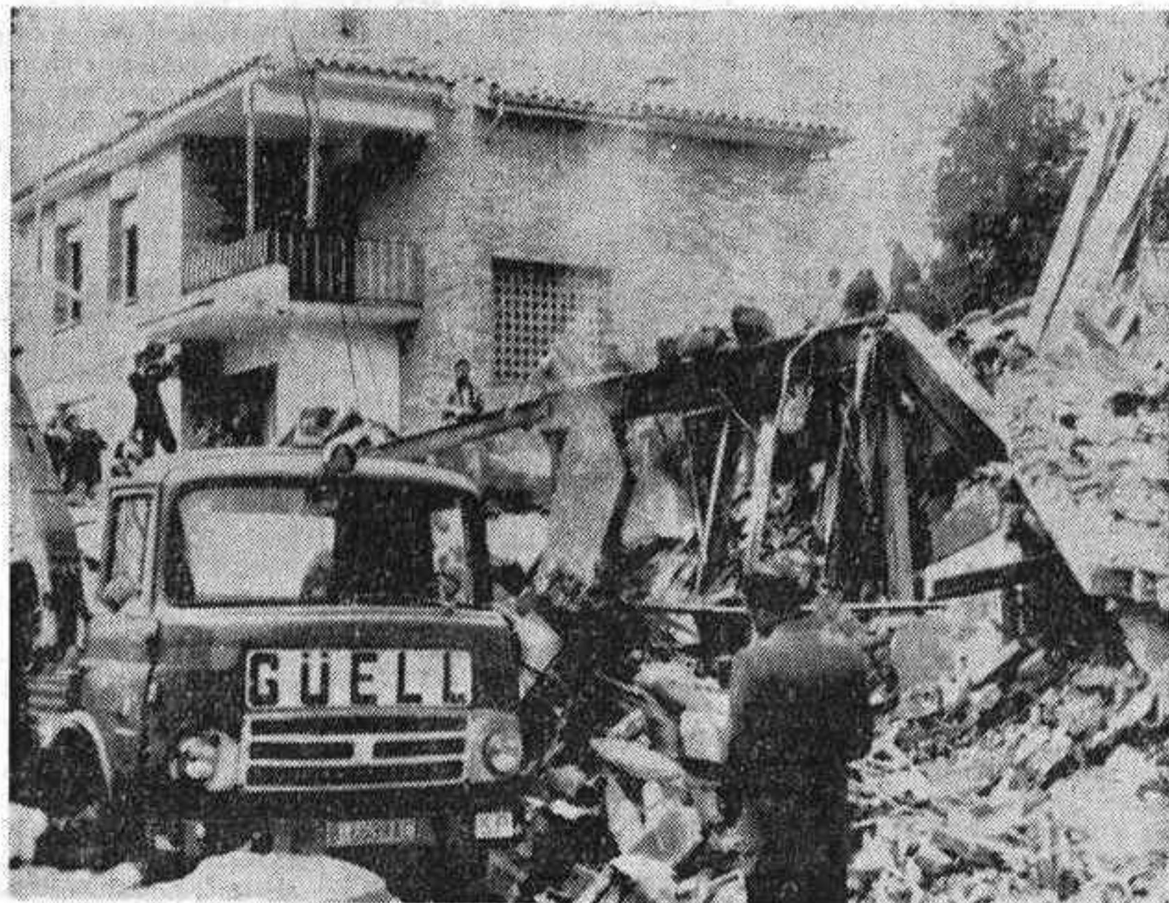
VICH (Barcelona). — Trabajos de desescombro de los dos edificios destruidos en esta localidad, al parecer por explosión de un depósito de gas propano, en los que se espera rescatar el cuerpo de una mujer desaparecida en el siniestro. — (Telefoto CIFRA GRAFICA)
