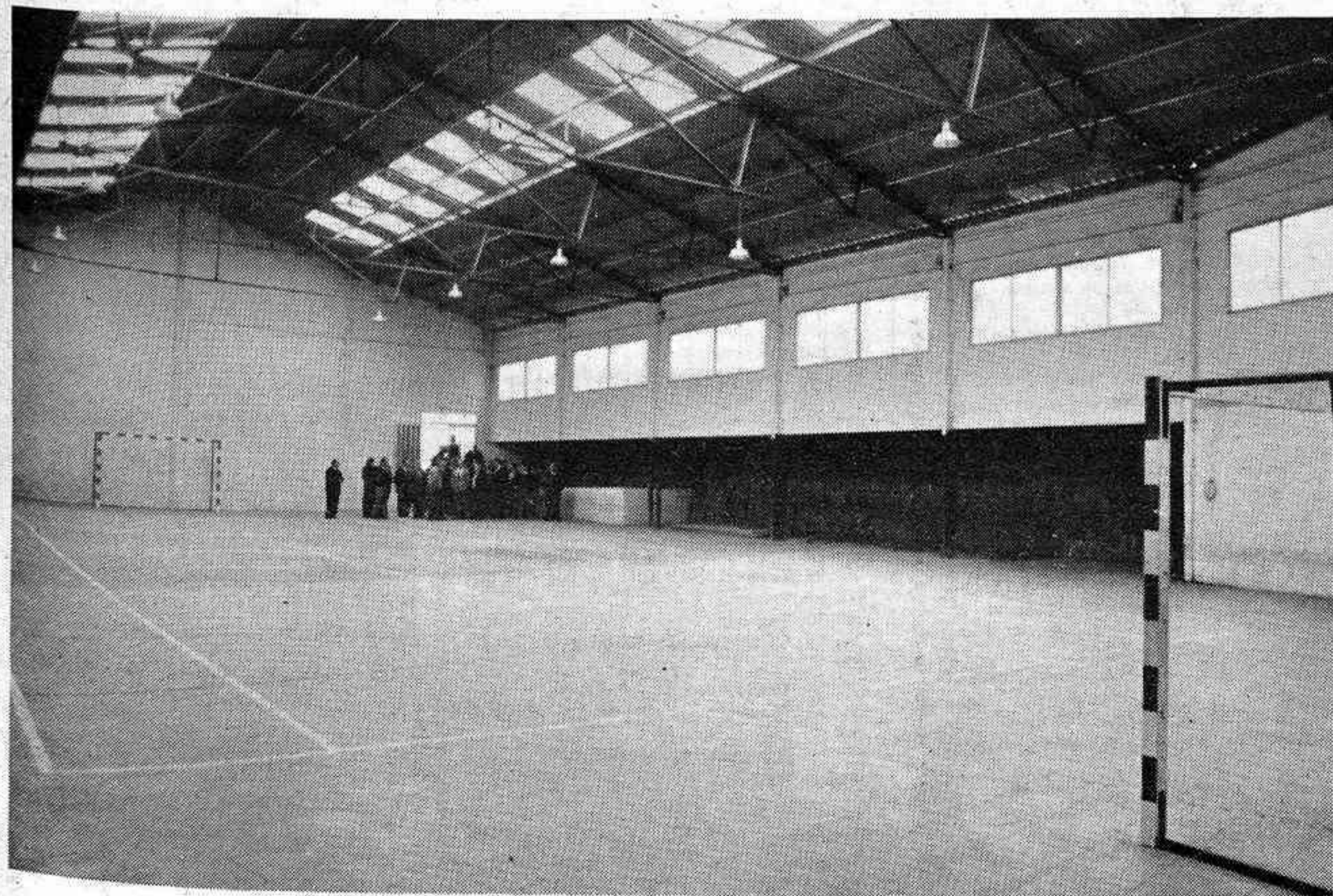
Pabellón polideportivo de Sierra Engarcerán, construido dentro del Plan Provincial de Obras y Servicios.
