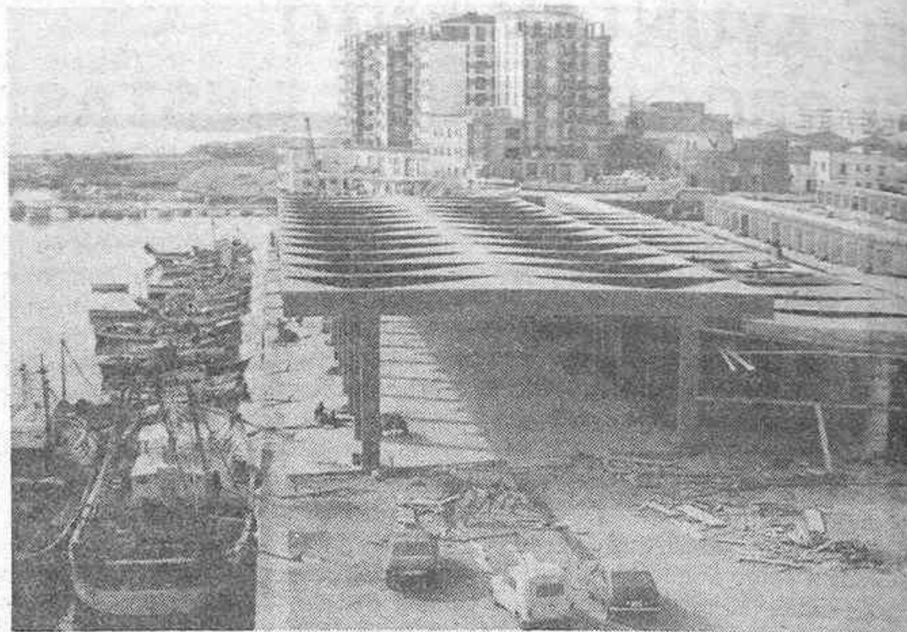
La nueva lonja de venta de pescado ha entrado en su tercera fase de construcción.
