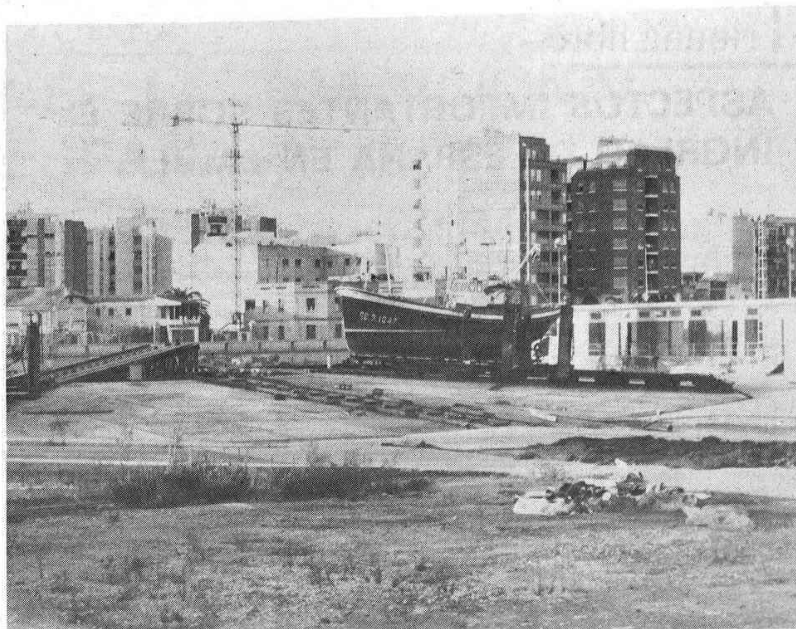
«Cualquier inspección cerraría dichas instalaciones»
