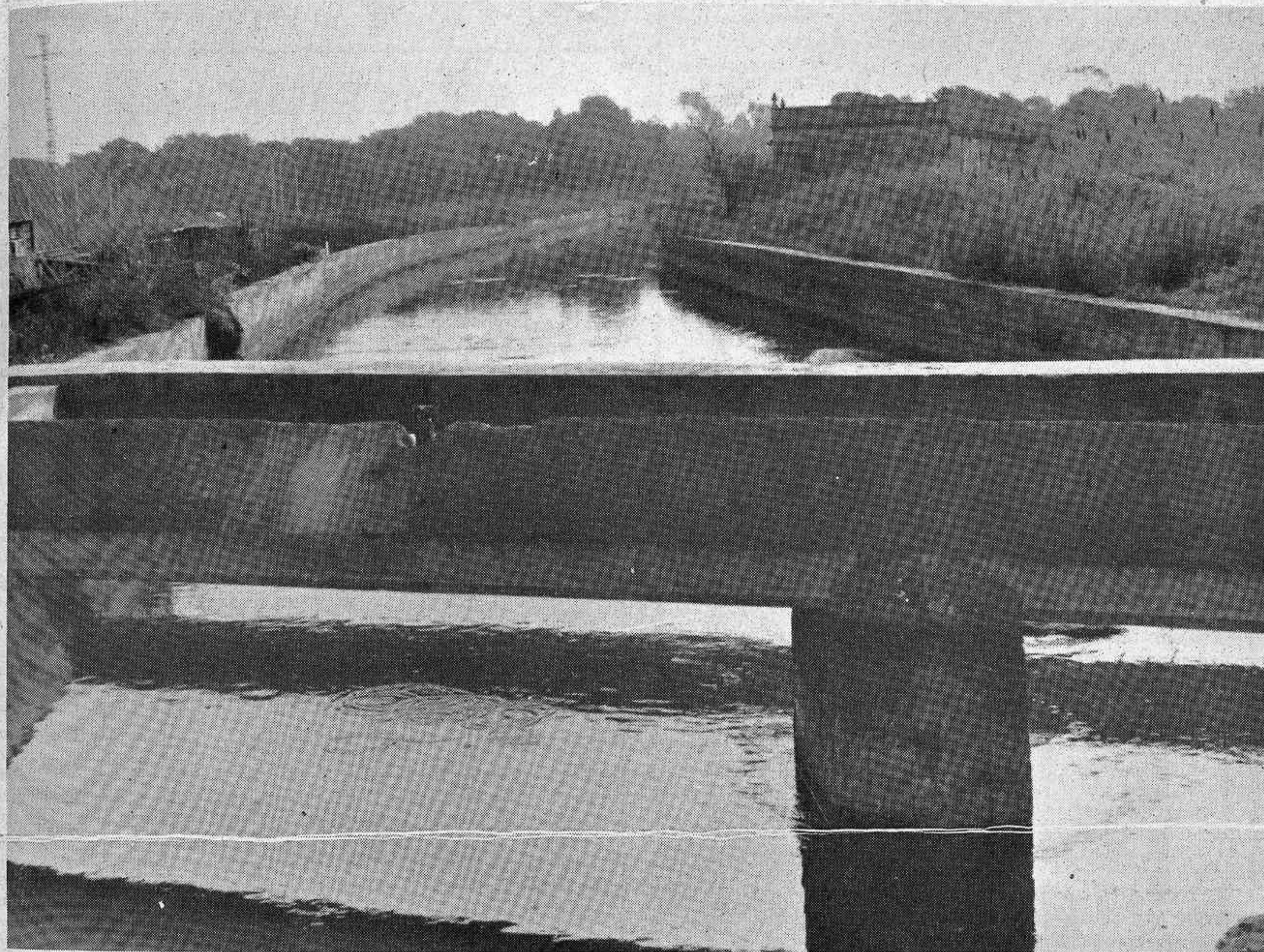
Camino de la Playa del Pinar, por la acequia de Entrilles pasa agua que, en parte, no ha sido depurada.
