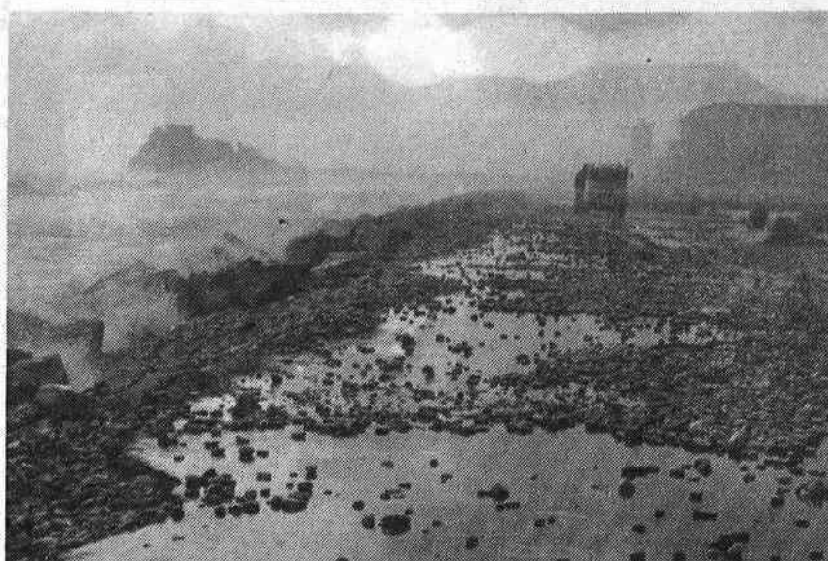
Estado en que queda la carretera CS-501 cuando se producen temporales de mar en la zona.
