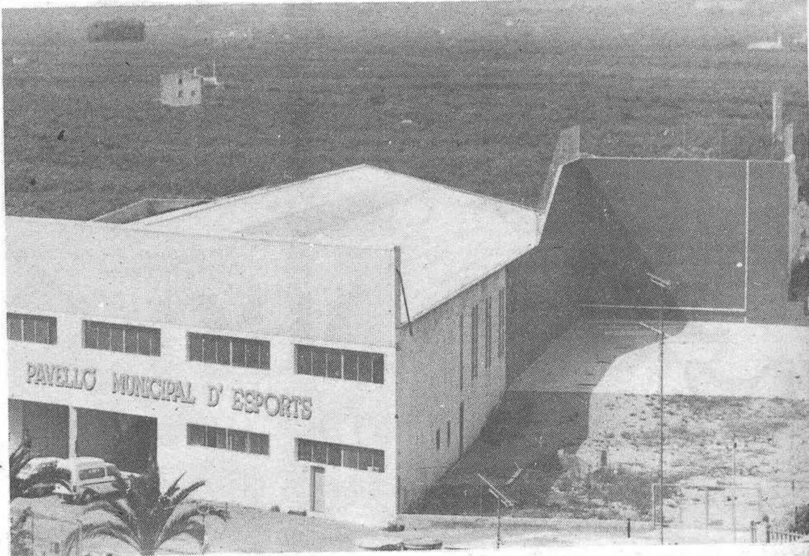
Instalaciones deportivas municipales de Almenara. (Foto: Hormigos)
