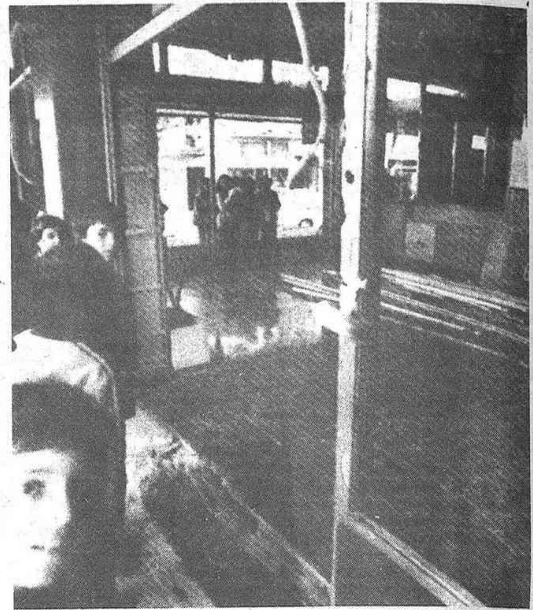
Estado en que quedó la sucursal del Banco de Bilbao de Lasarte tras la explosión de un artefacto compuesto por tres kilos de Goma-2.
