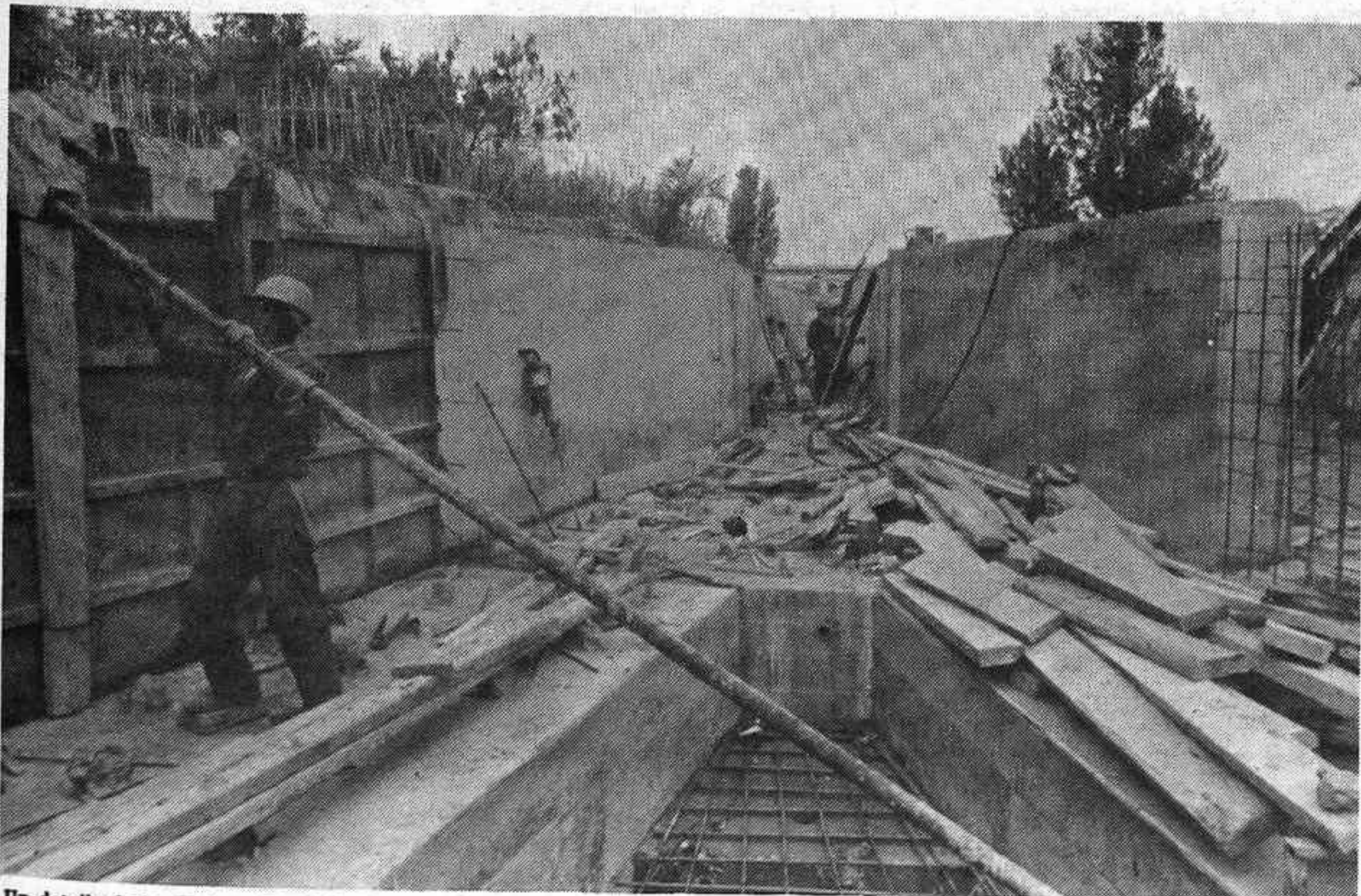
Un detalle de la construcción de la presa
