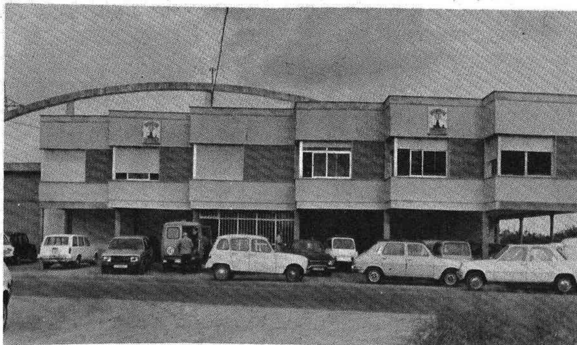
Las instalaciones de la Cooperativa «San Miguel», en la avenida de Valencia.
