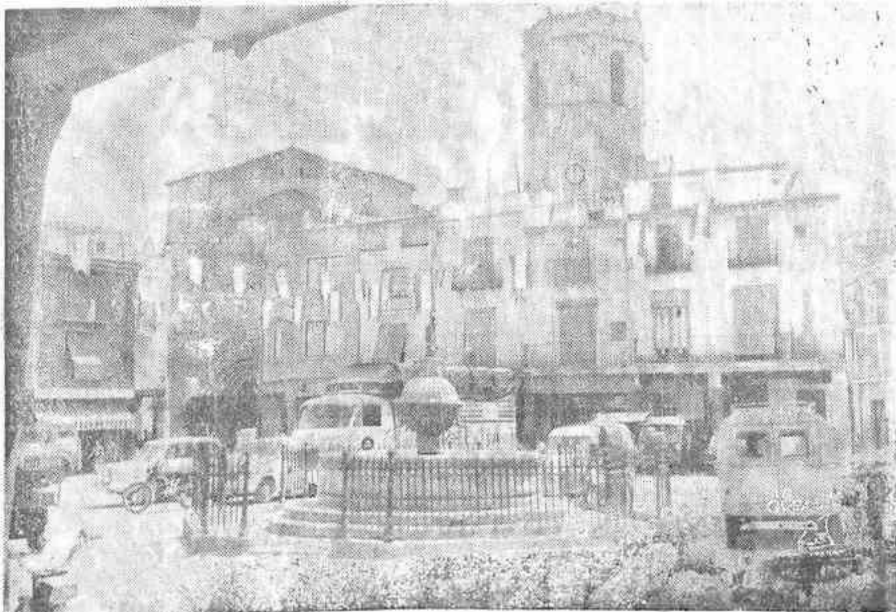
Vista del Caudillo, centro de la vida de San Mateo. Al fondo, la Iglesia Arcipresbital
