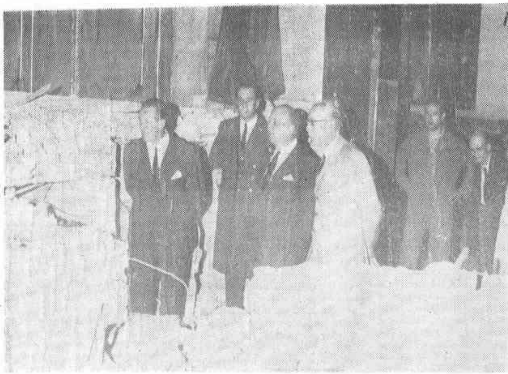
MADRID. — El Presidente de las Cortes, señor Rodríguez de Valcárcel, durante su visita a las obras que se realizan en el Palacio de las Cortes, una vez finalizada la legislatura. Las obras comenzaron al día siguiente de la última sesión plenaria. — (Foto CIFRA)
