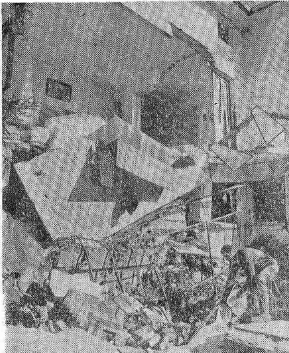
TRISAGHIS (Italia). — Una de las casas de esta localidad destruida por los efectos del seísmo que afectó a la zona durante el miércoles pasado. Esta región italiana ya sufrió los efectos de un seísmo el pasado mes de mayo, que alcanzó una intensidad de 6,3 en la escala de Richter. — (Telefoto CIFRA GRAFICA-UPI)
