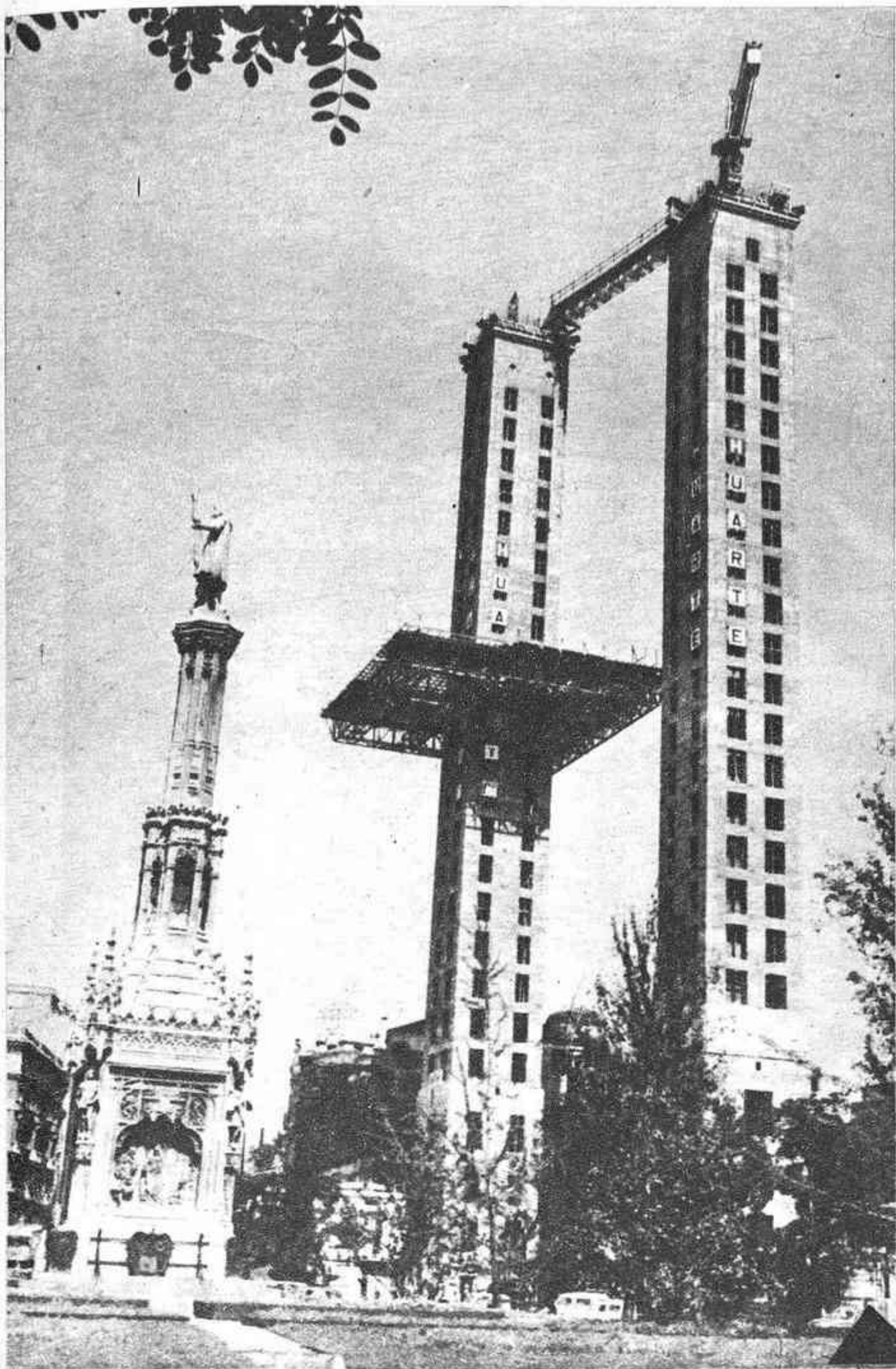
Continúa la construcción de las gigantescas torres en la madrileña Plaza de Colón. Como se sabe se trata de dos altos bloques de los que se ha levantado su estructura central, siguiendo ahora la construcción del resto de los edificios según el sistema denominado "método del paraguas", empleado por vez primera en España. La foto muestra el estado actual de las obras. — (Foto FIEL)
