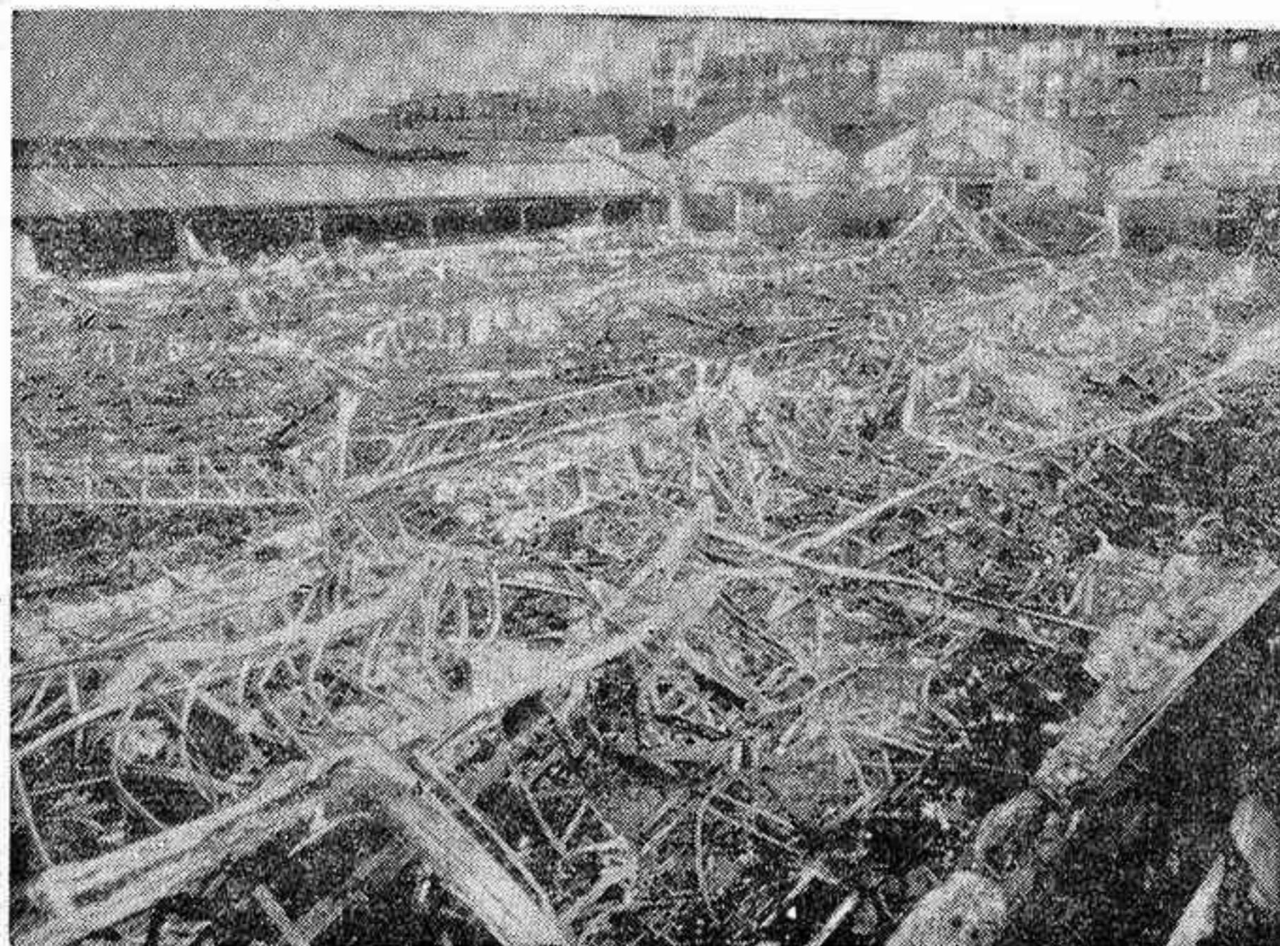
PARIS. — Sólo hierros retorcidos de las instalaciones para la exposición de elementos del hogar, han quedado en pie de la Feria de París, después de un tremendo incendio que destruyó todo lo que había en el interior bajo techo. Los bomberos lucharon para extinguir el fuego durante más de tres horas, hasta conseguir el control total sobre las llamas. — (Telefoto Cifra Gráfica-Up)
