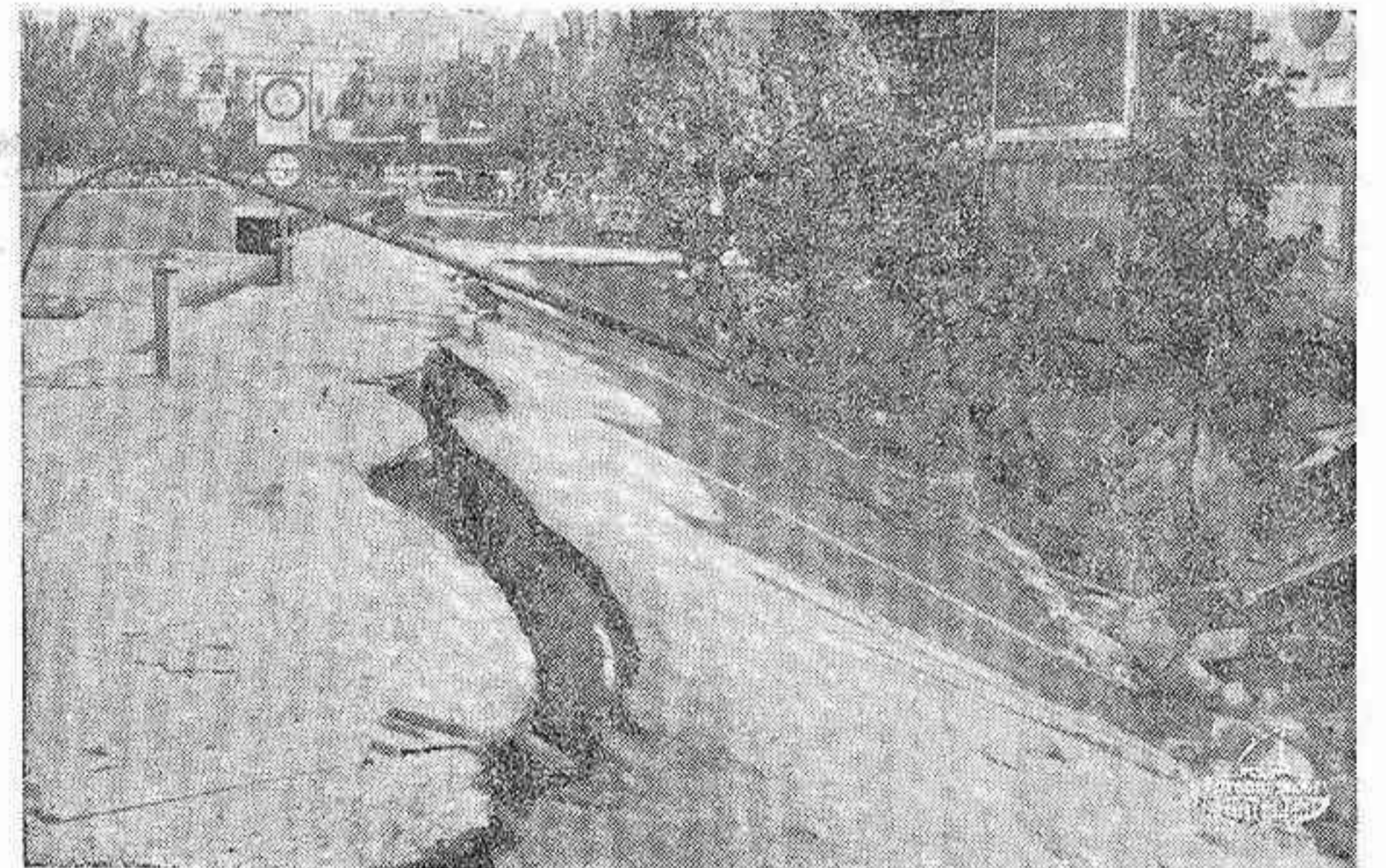
MADRID.— Dos aspectos de los daños habidos a causa del hundimiento por la rotura de una cafetería y las explosiones de gas y los incendios subsiguientes registrados anoche poco más de las once en la zona de las calles de Joaquín Costa y Francisco Silveira. Parece ser que sólo son dos los heridos de alguna gravedad, por quemaduras. — (Foto Cifra Gráfica).
