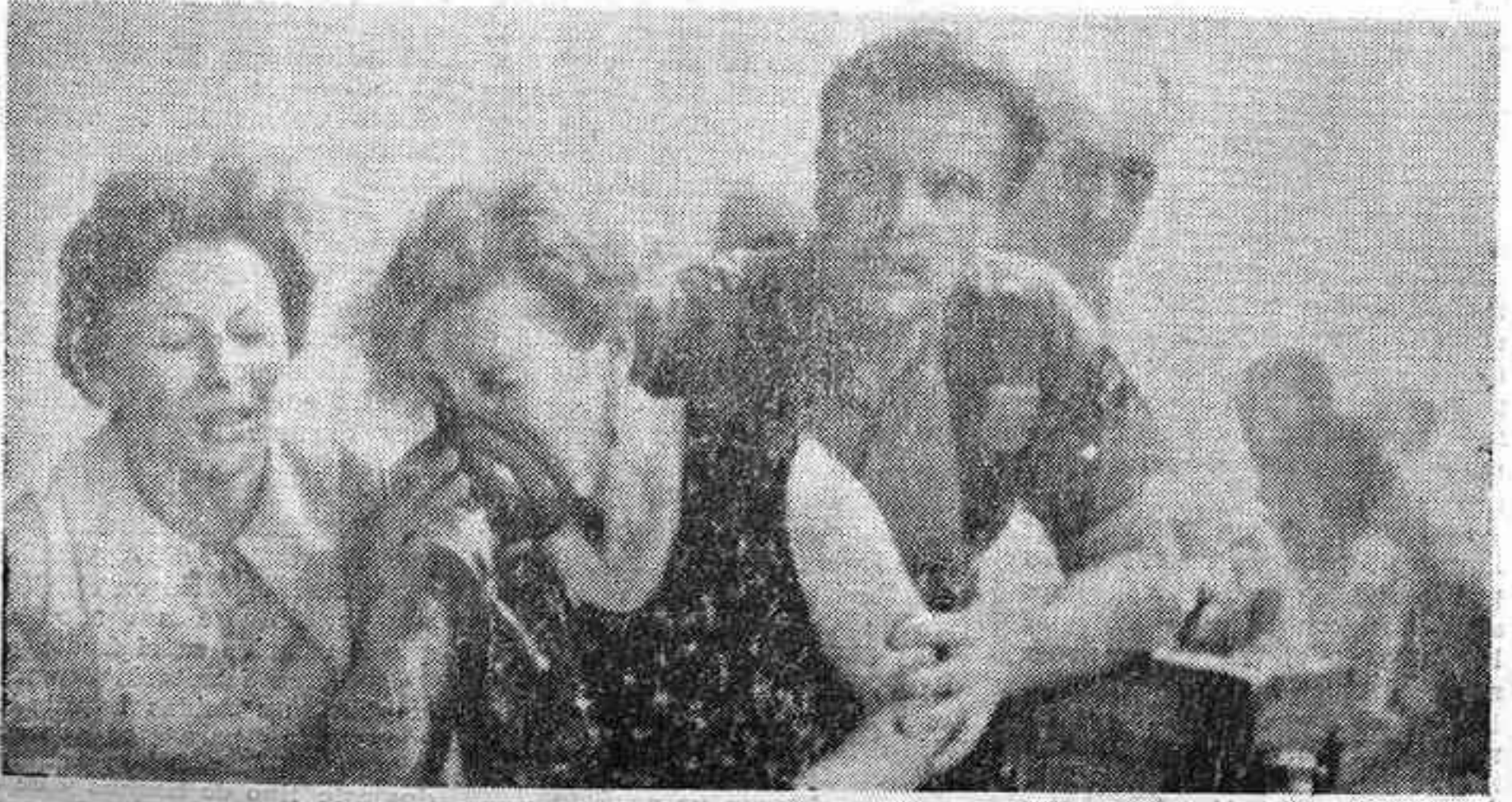
NUEVA YORK.—Una mujer es auxiliada con una mascarilla de oxígeno por un policía al ser sacada de una estación del Metro. Parte de un túnel se hundió sobre un tren cargado de viajeros, en la hora punta de la tarde. Hubo que evacuar a miles de personas por una de las estaciones, llena de humo.—Telefoto Cifra GráficaUpi
