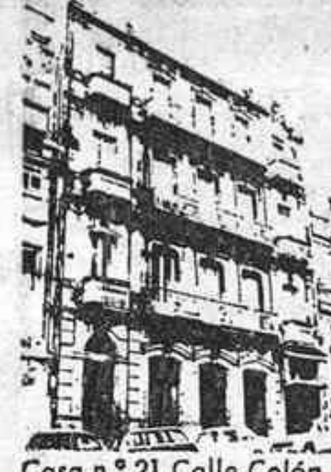
Casa n.º 21 Calle Colón. Compuesto de 2 viviendas y 2 locales comerciales. VIGO
