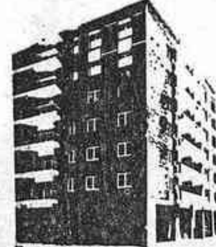
Casa n.º 32-36 calle La Mina. Compuesto de 5 locales comerciales y 63 viviendas. BADALONA
