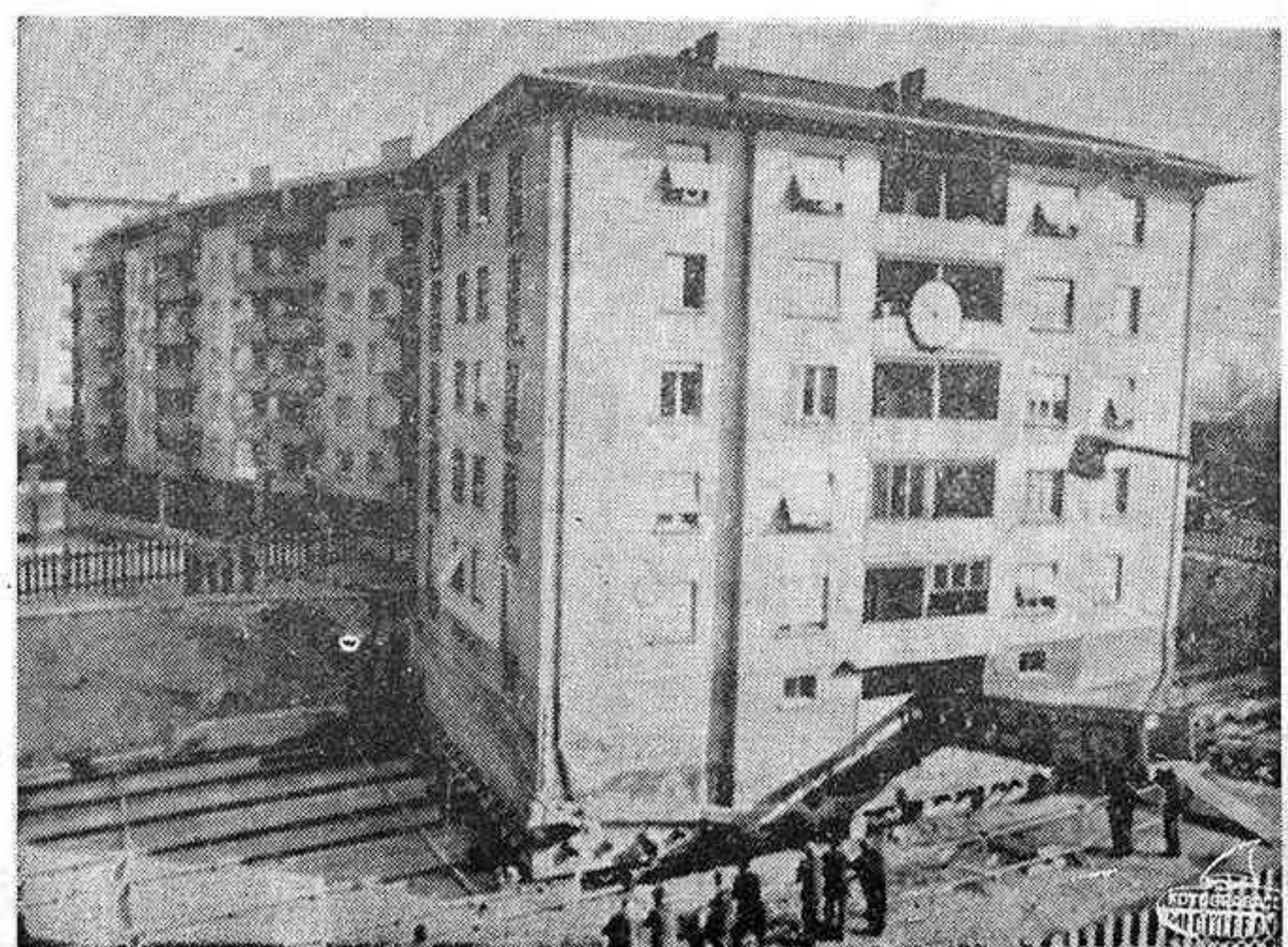
BASILEA. — Para la construcción de una nueva autopista, esta casa de cinco plantas, de 3.800 toneladas de peso, construida en 1954, ha sido desplazada en dirección diagonal, 28'63 metros al oeste y 2'68 m. al sur. (Telefoto CIFRA)
