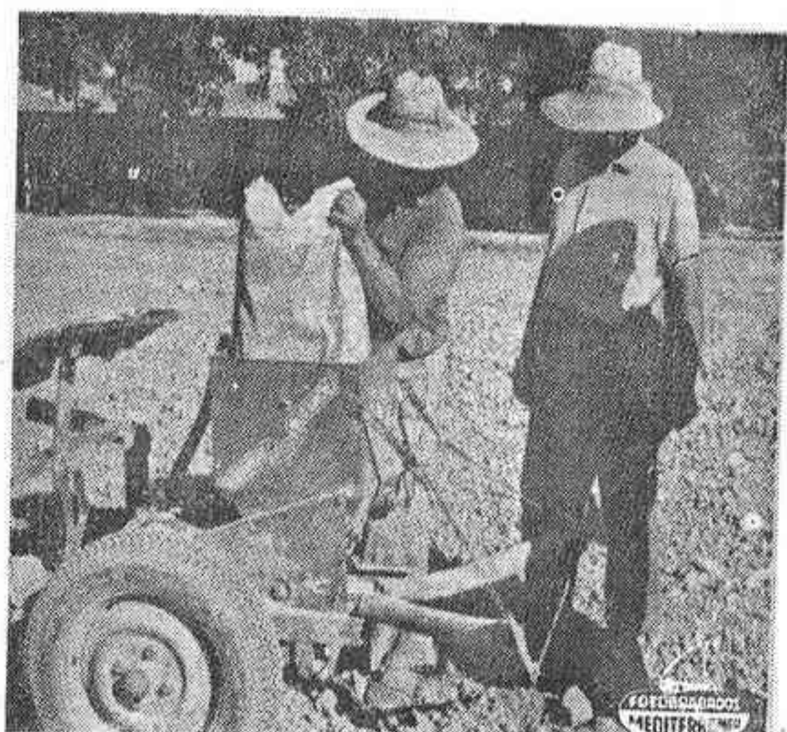
Espolvizador con las bocas de salida inclinadas hacia el suelo para reparar Lindano.
