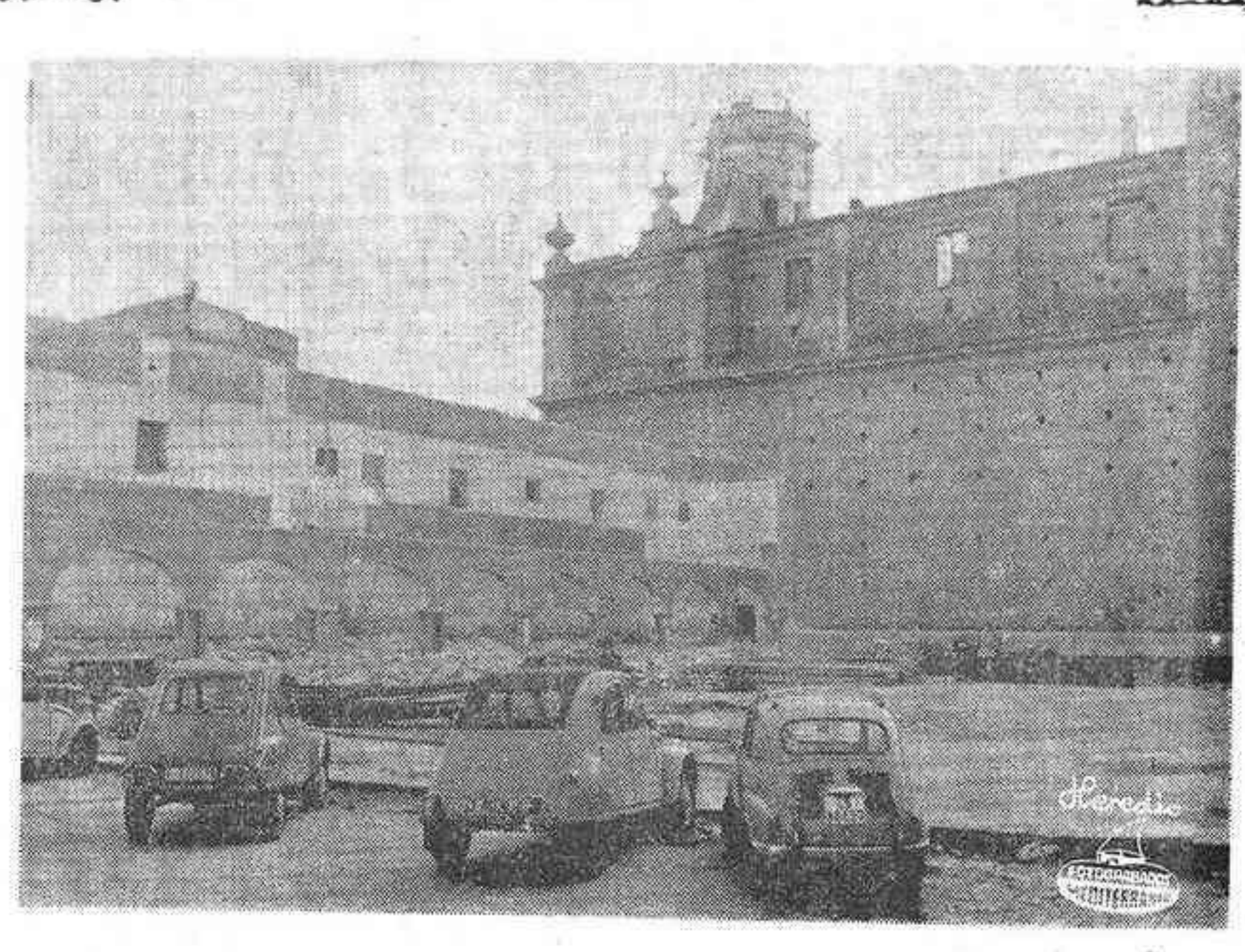
Demolido el viejo mercado, pronto surgirá una nueva e importante obra
