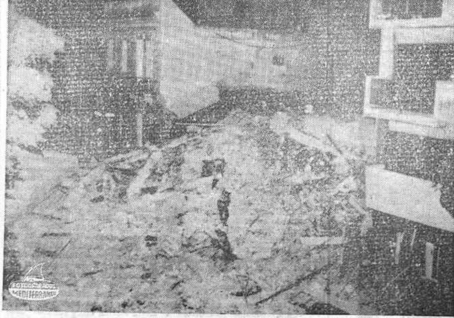
BUENOS AIRES. - Miembros de las brigadas de rescate trabajando en la búsqueda de posibles víctimas después del derrumbamiento de un edificio en construcción de catorce pisos. El derrumbamiento sobrevino cuando una piscina instalada en un piso alto perdió toda sa agua debido a una rotura. - (Telefoto UPI\_CIFRA)
