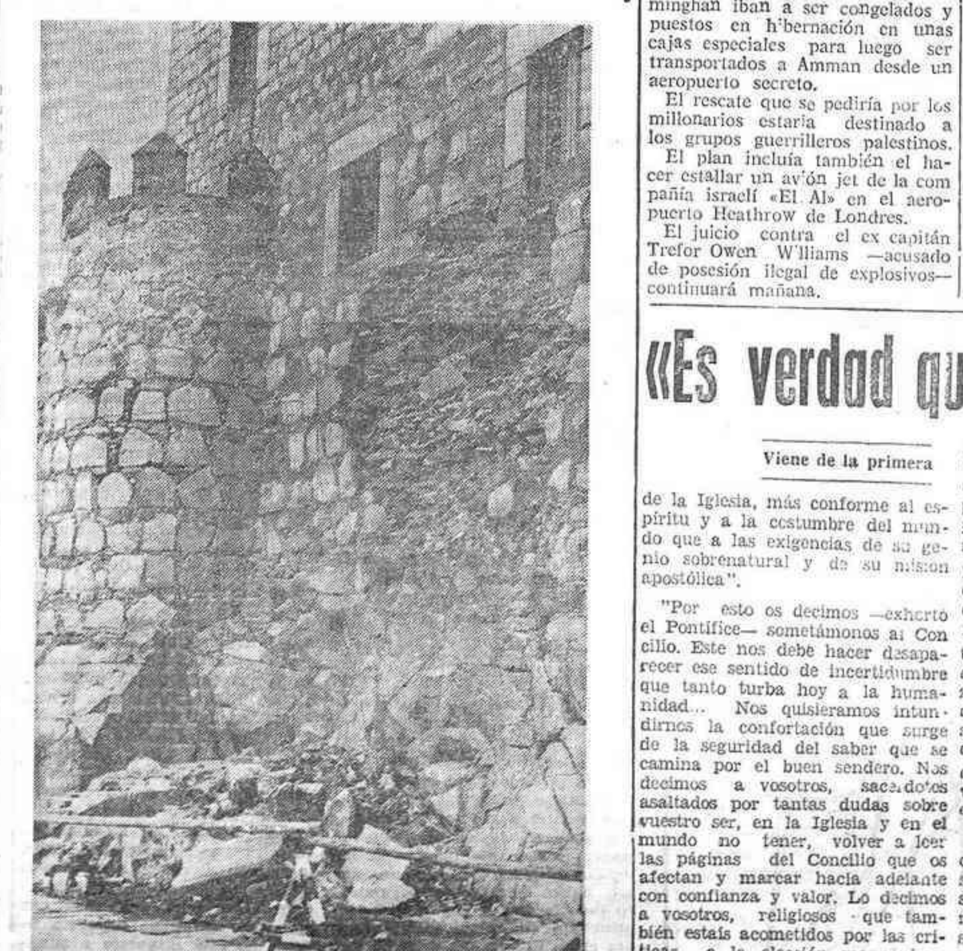
AVILA. — Como consecuencia de las fuertes lluvias cayeron estos días sobre esta provincia, se derrumbó un bloque de unos doce metros cuadrados de granito de la muralla, en su lienzo del Paseo del Rastro, bajo los ventaneros del Palacio Episcopal. — (Foto CIFRA GRAFICA)
