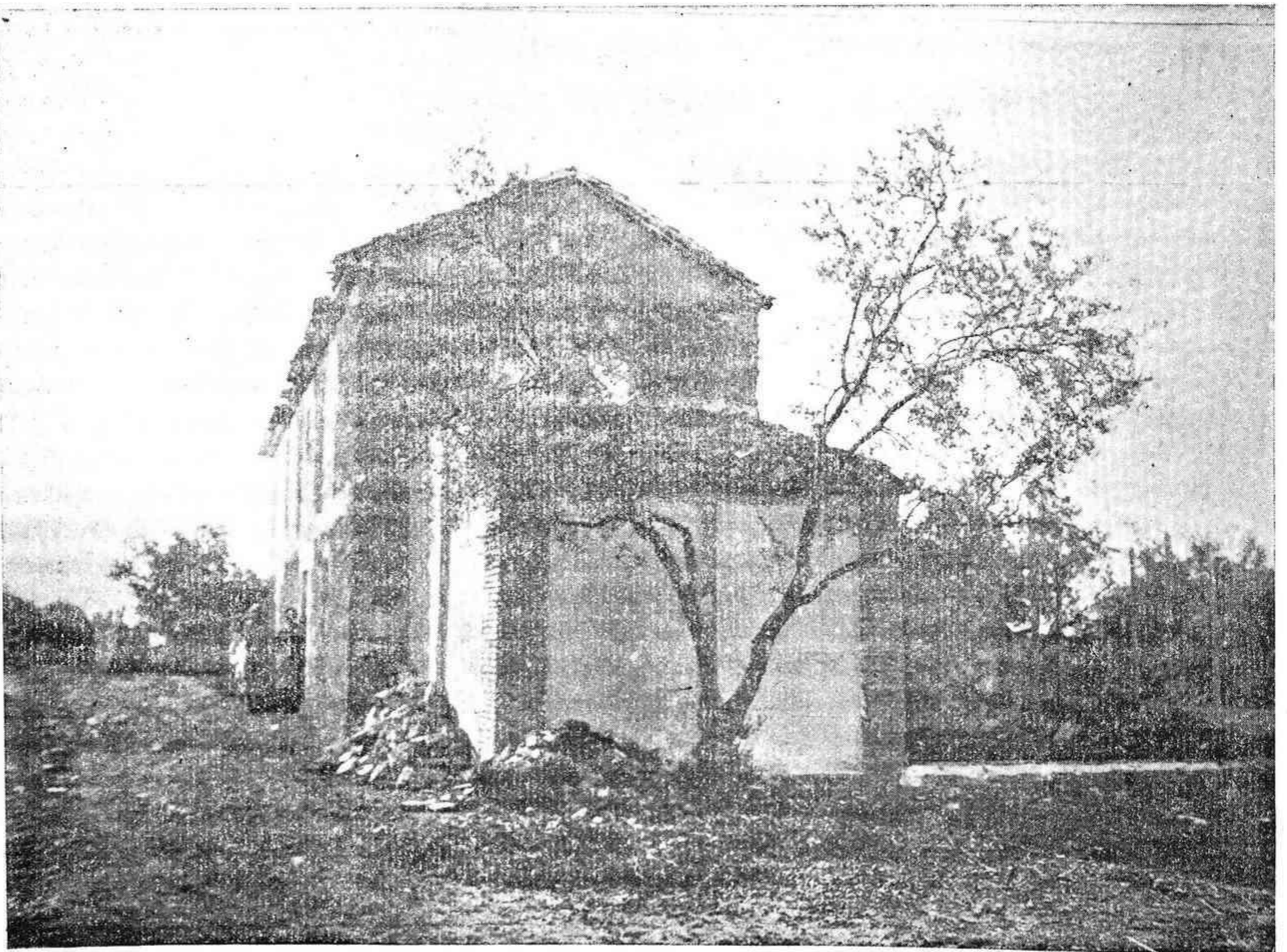
Esta casa sufrió grandes deterioros, habiendo destruido el granizo la techumbre. El olivo que se vé en primer término dá idea de la violencia del apedreo.
