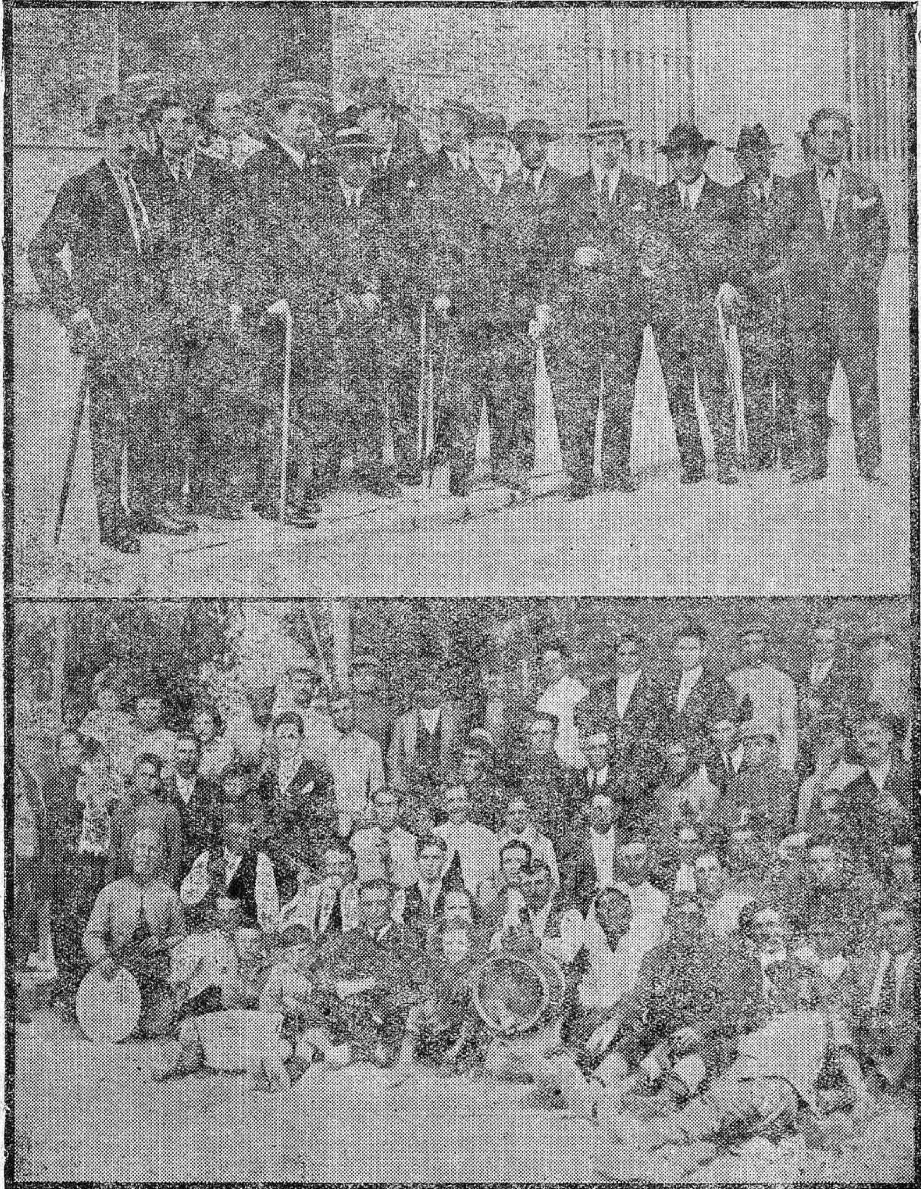
El señor Cruz Conde, con las autoridades e invitados al acto de la inauguración de la nueva y magnífica Casa de Socorro.---Los obreros que han intervenido en las obras del Gran Capitán, que fueron obsequiados con un clásico perol por la terminación feliz de aquéllas.
