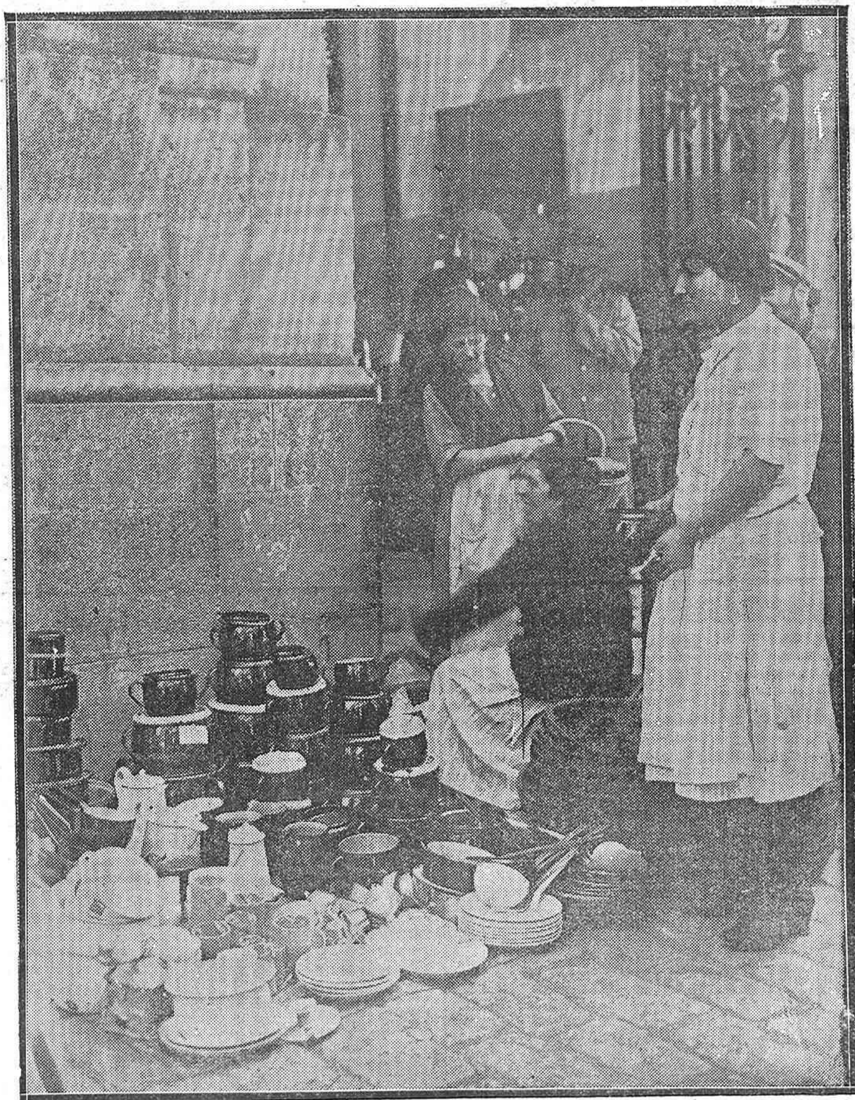
ESCENAS CALLEJERAS.—Uno de los típicos puestos de vajilla barata y batería de cocina que se establecen por la mañana en la plaza de la Corredera.
