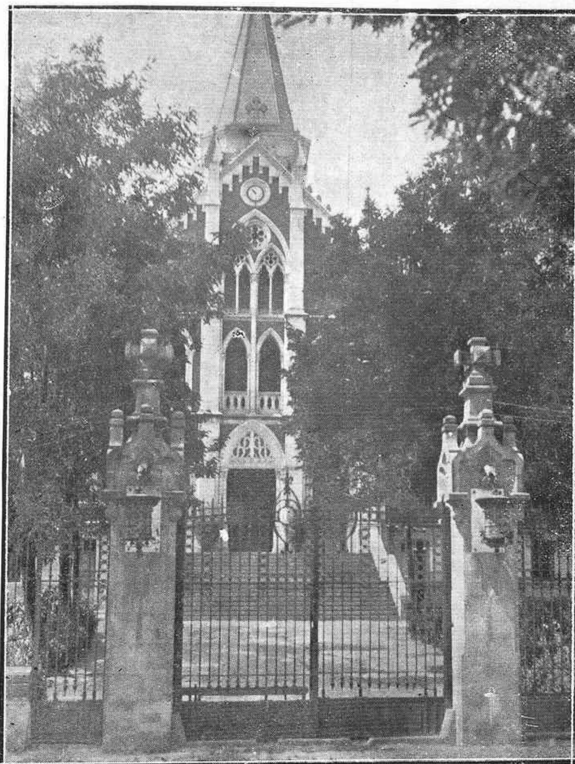
El nuevo Hospital.-Fundación de los Marqueses de Linares
