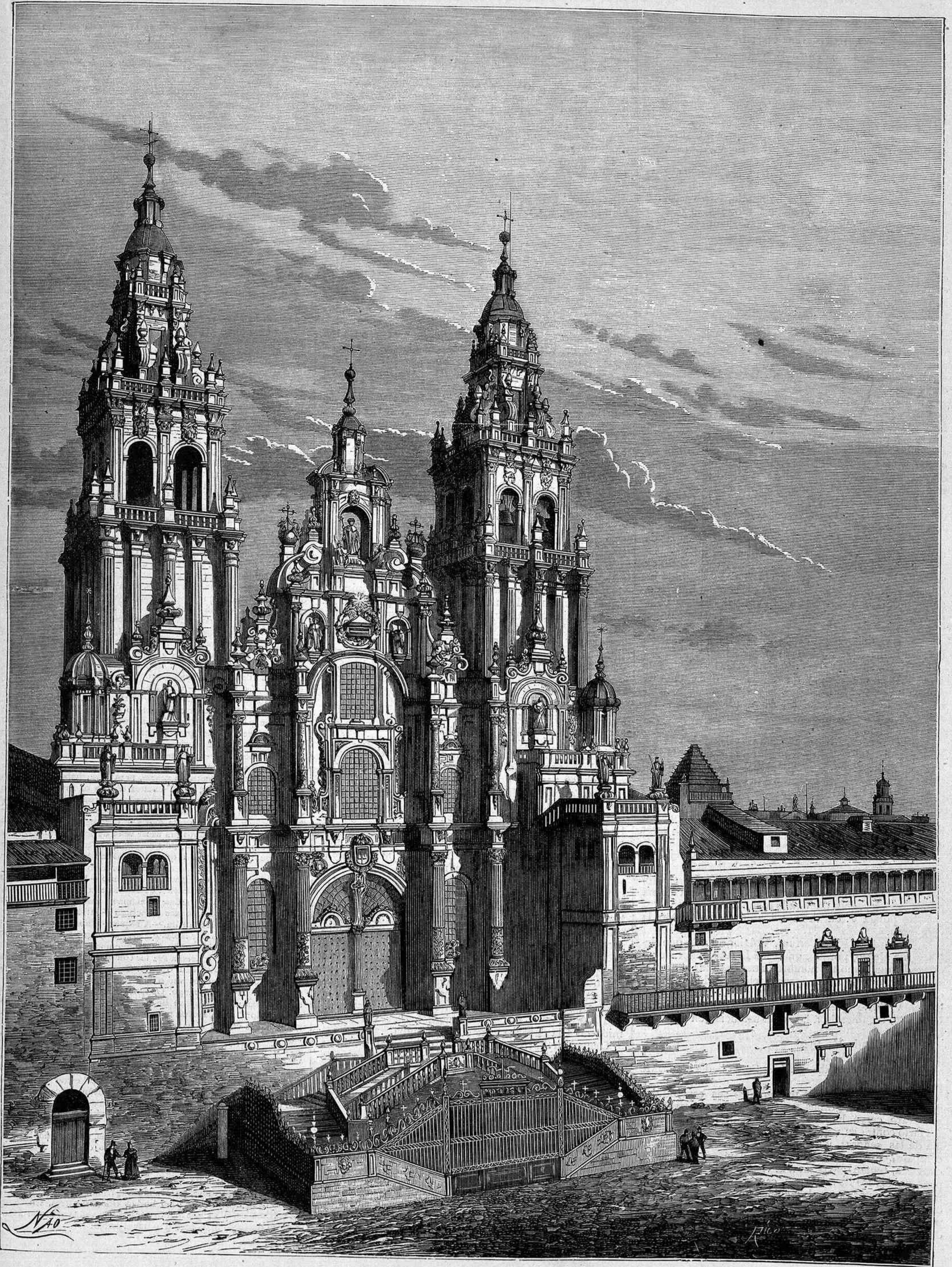
FACHADA LLAMADA «DEL OBRADOIRO» EN LA CATEDRAL DE SANTIAGO.
