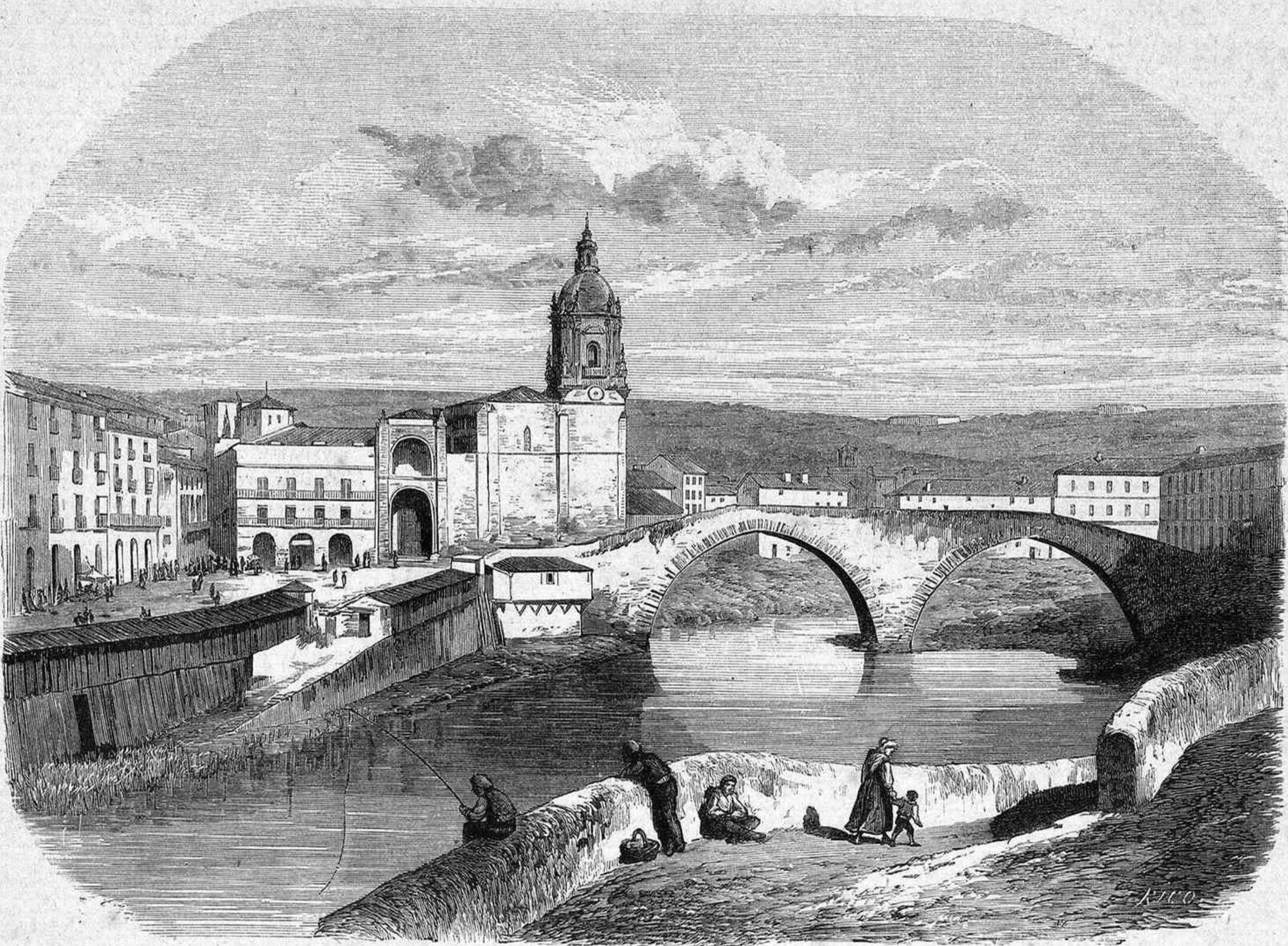
BILBAO: EL PUENTE VIEJO, HUNDIDO EL DIA 3 DEL CORRIENTE.
