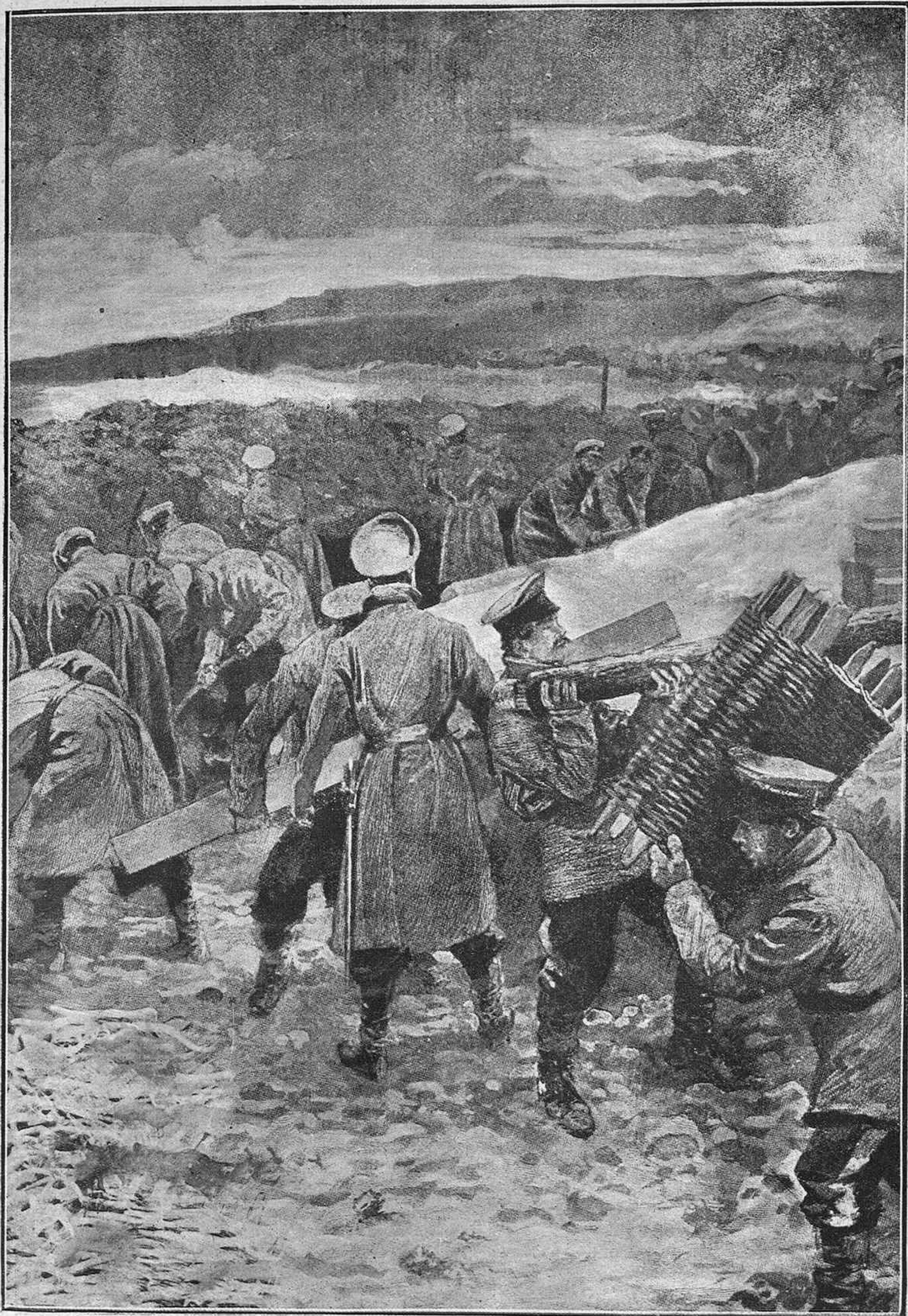
CONSTRUCCIÓN DE UNA TRINCHERA EN LOS CONTORNOS DE PORT-ARTHUR (De una instantánea remitida á «The Graphic» desde el teatro de la guerra)
