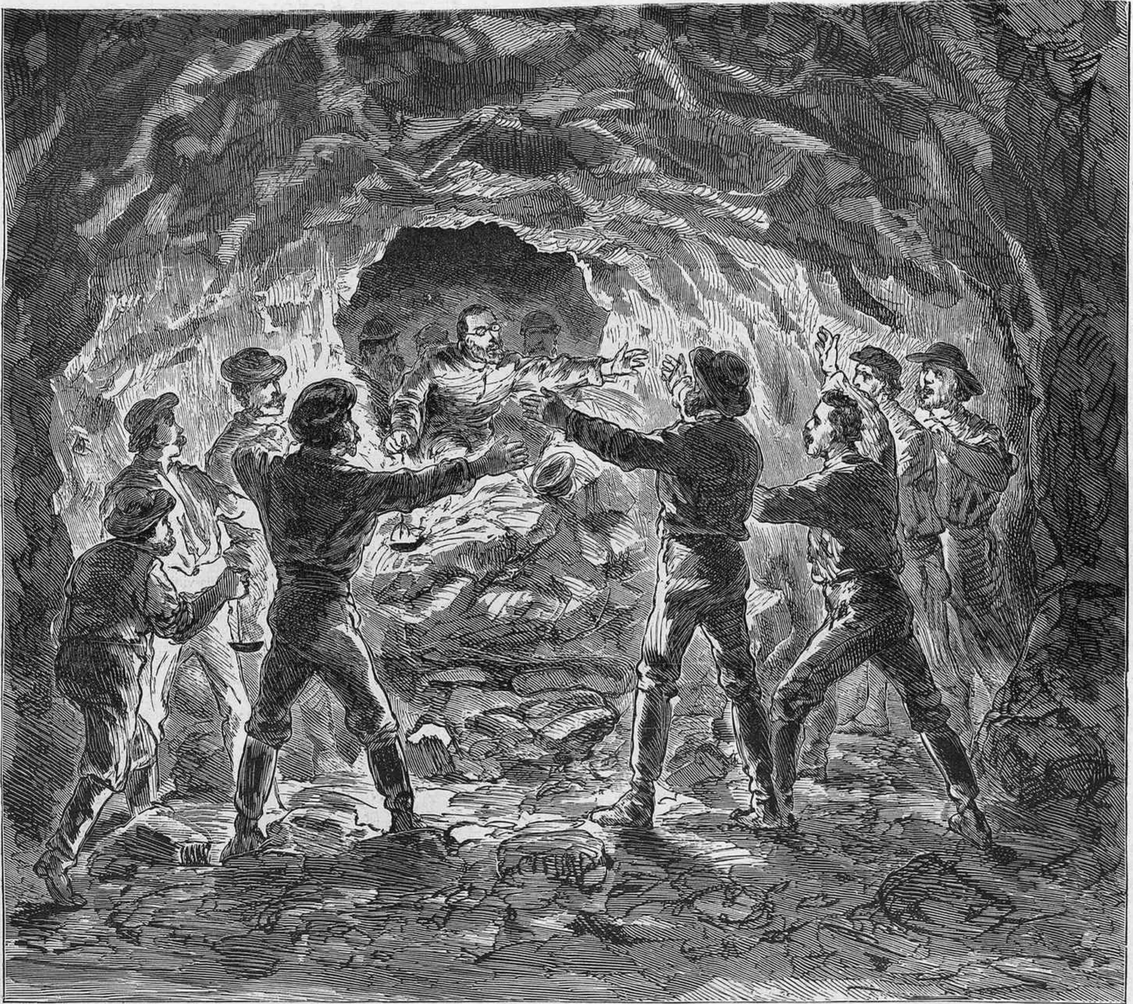
Encuentro de los operarios de las dos secciones del túnel
