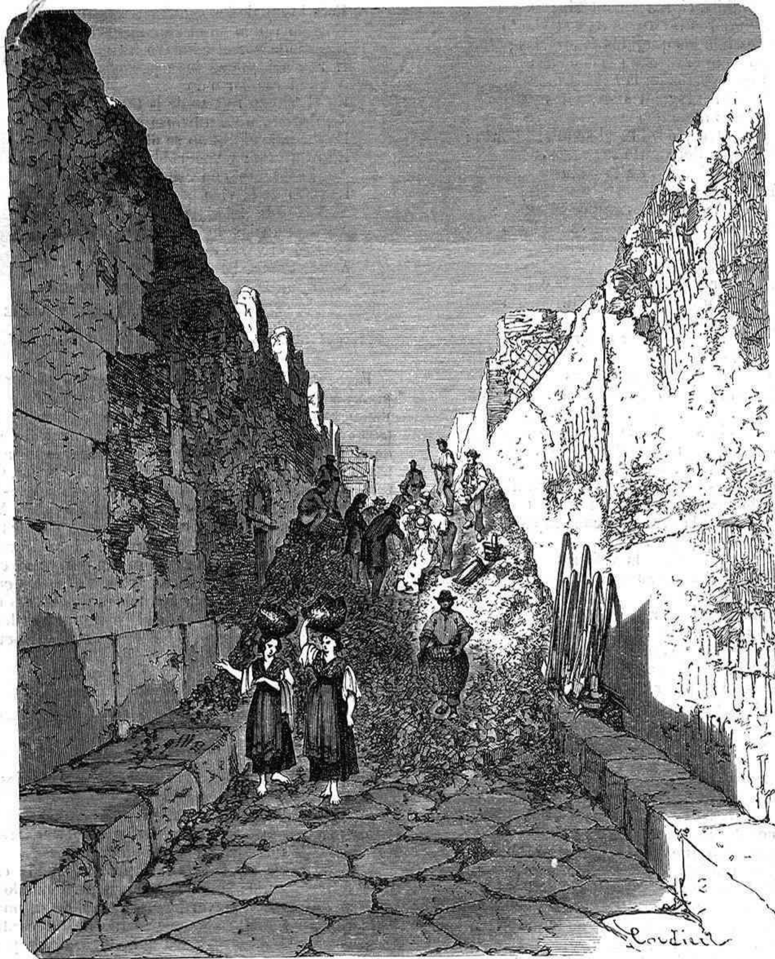
ESCAVACIONES EN UNA CALLEJUELA DE POMPEYA.
