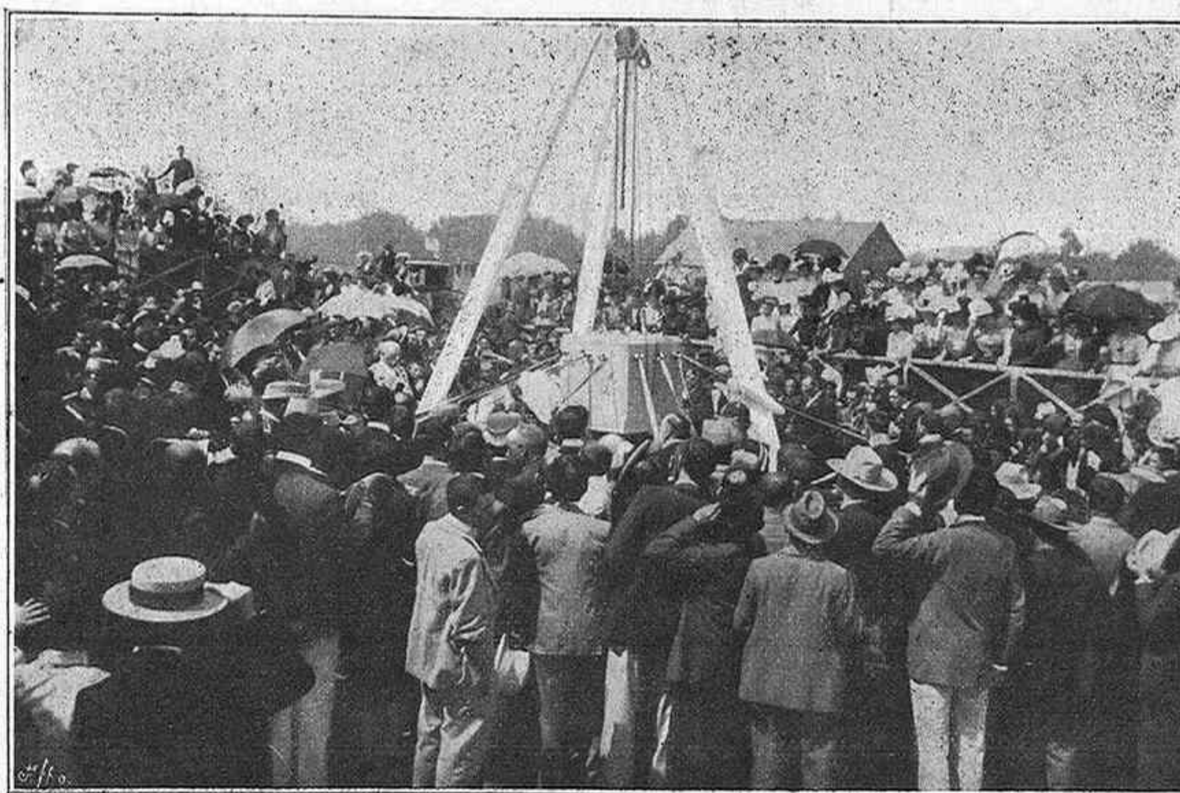
VIAJE DE SS. MM. Y AA. - GIJÓN. - Colocación de la primera piedra del Cuartel de Alfonso XIII (de fotografía de D. Ricardo del Río, Gijón).
