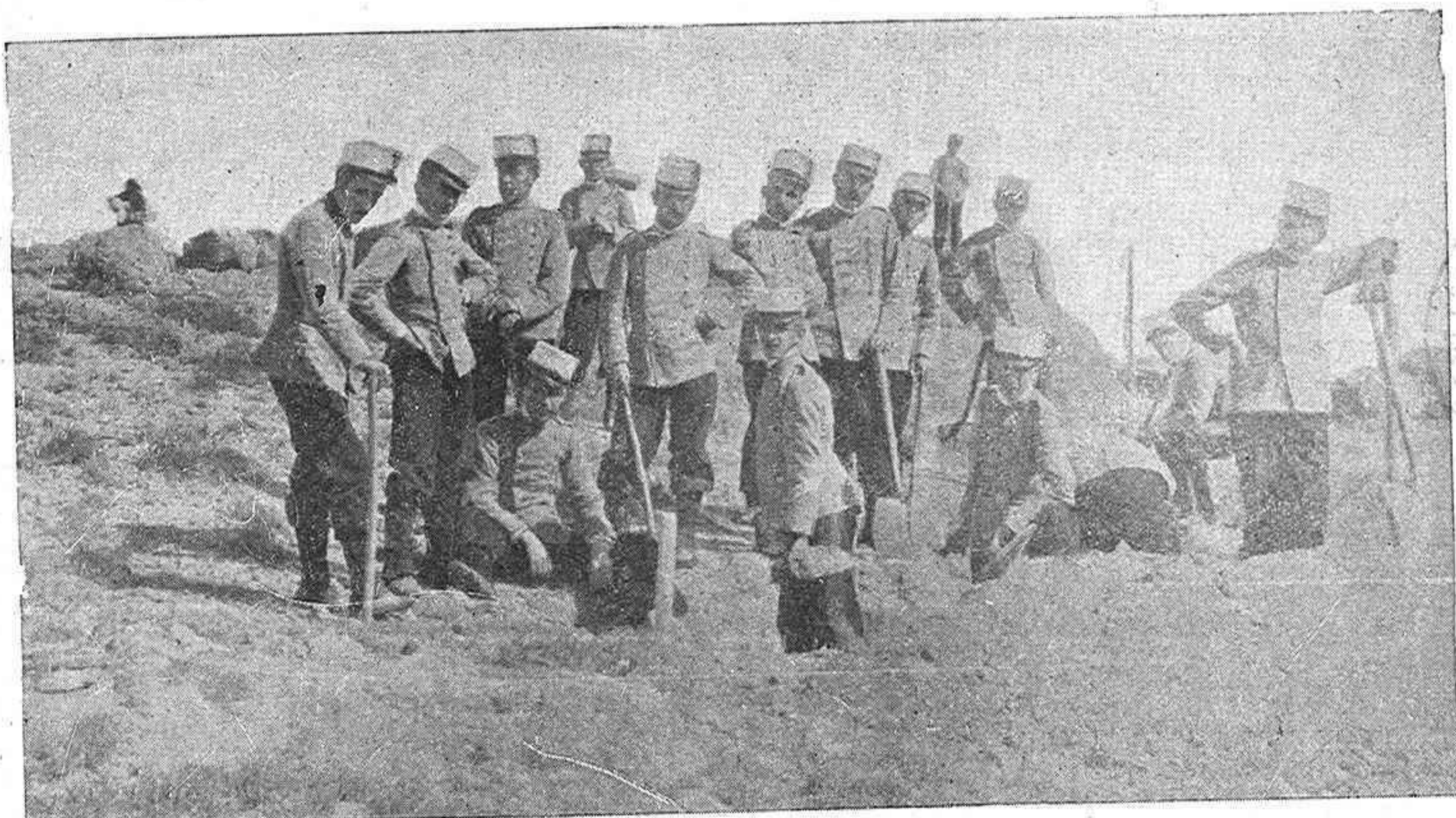
PRÁCTICAS DE CAMPAMENTO—TRABAJOS DE FORTIFICACIÓN
