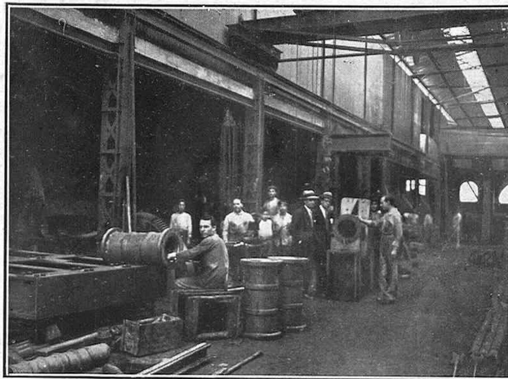
Otro detalle de los Talleres de Fundición de los Hijos de Enrique Sánchez, donde podrá ver el lector la fabricación de las famosas bombas de pistón
