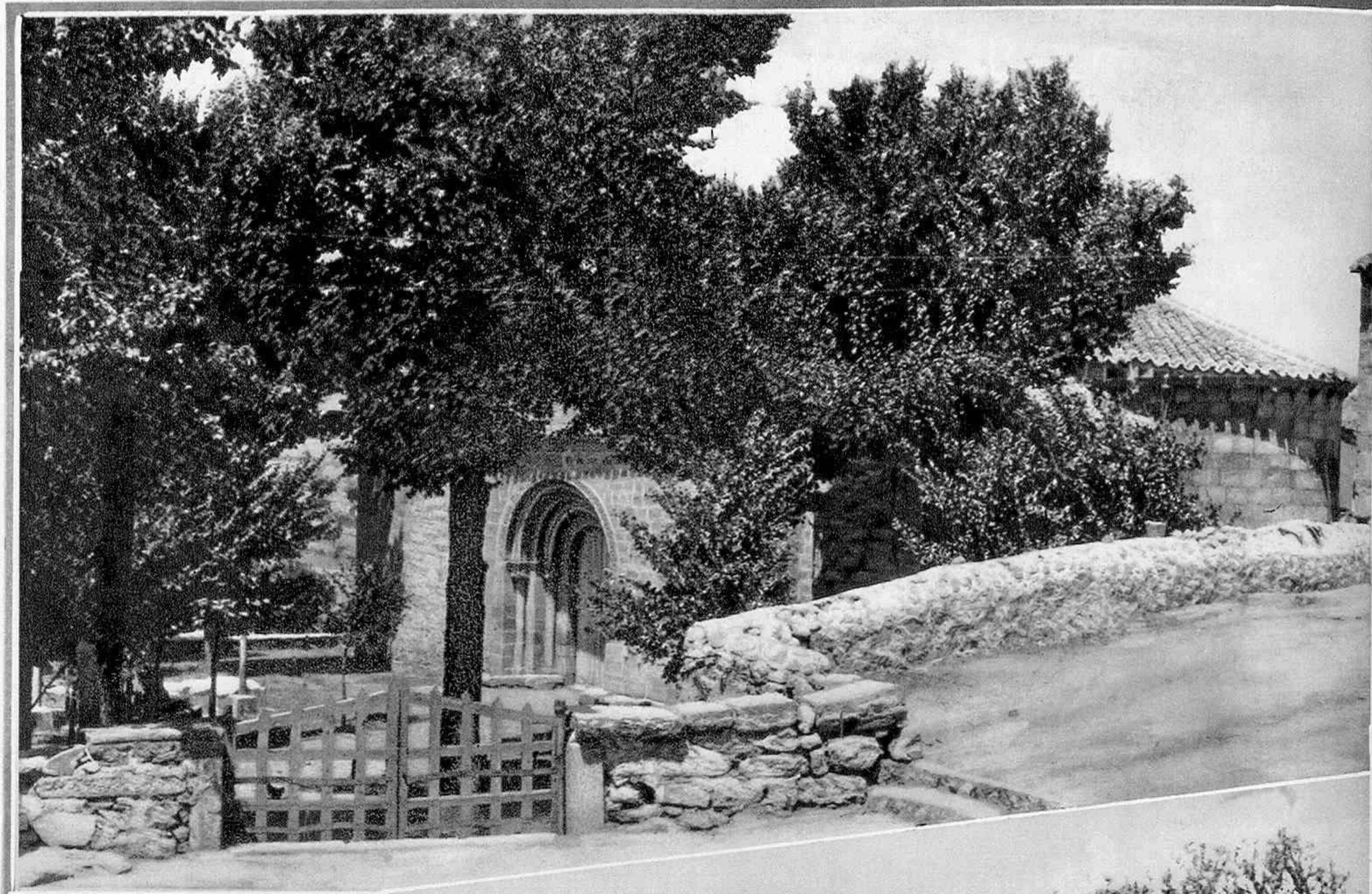
Fachada principal, de clásico estilo románico, de la Ermita de San Segundo
