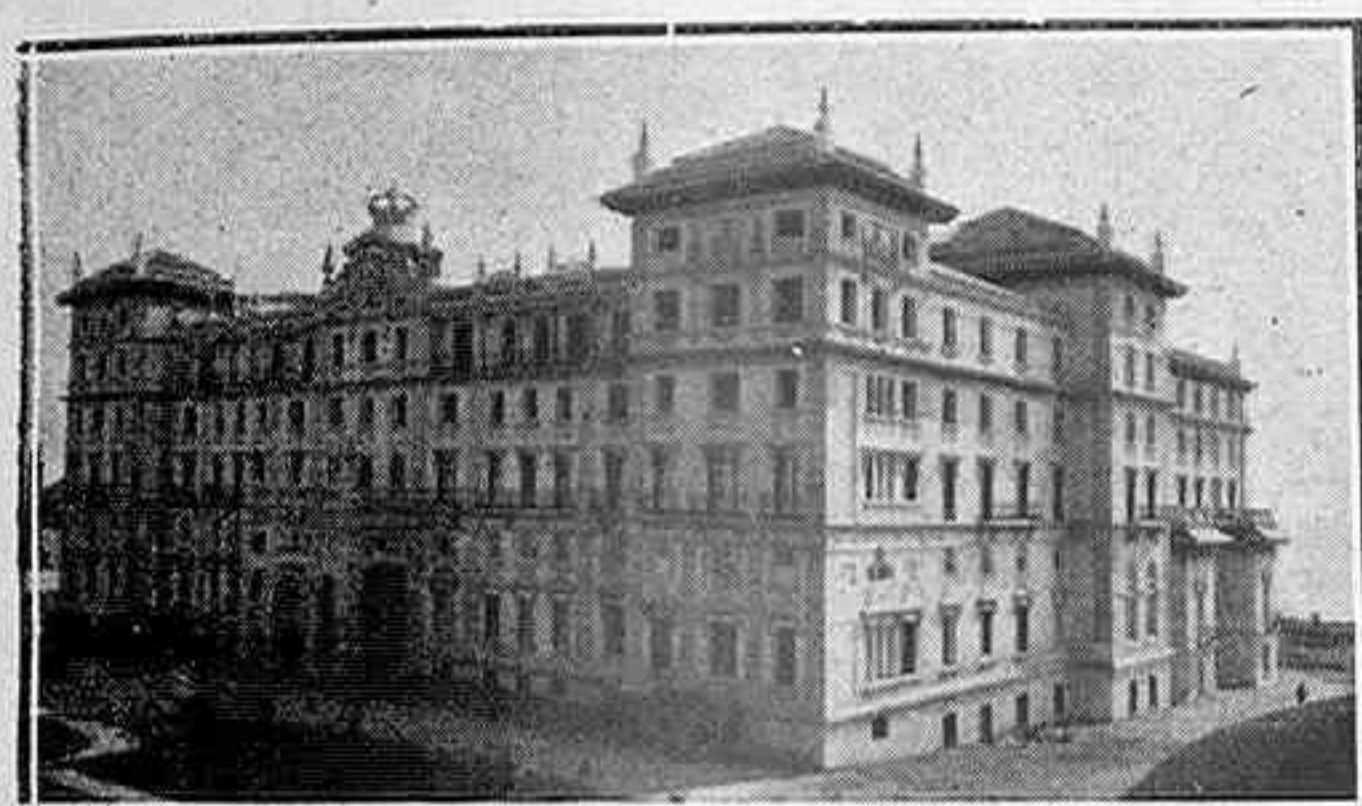
«Hotel Príncipe de Asturias».—Fachada principal
