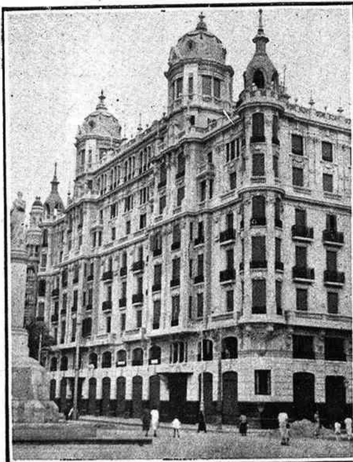
Alicante.—Casa denominada Palacio Carbonell, sita en el Paseo de los Mártires, núm. 1
