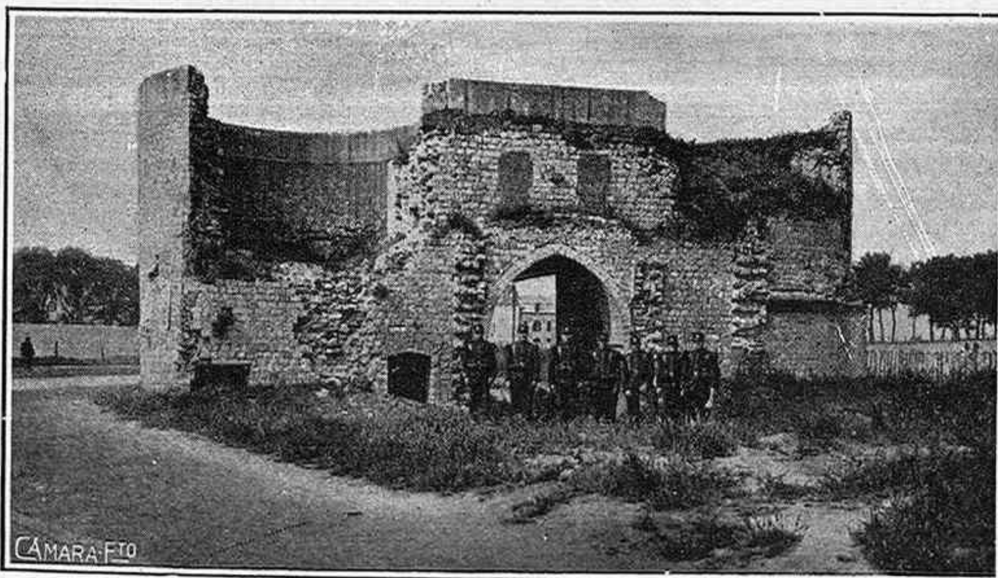
Torre de la puerta de Arras
