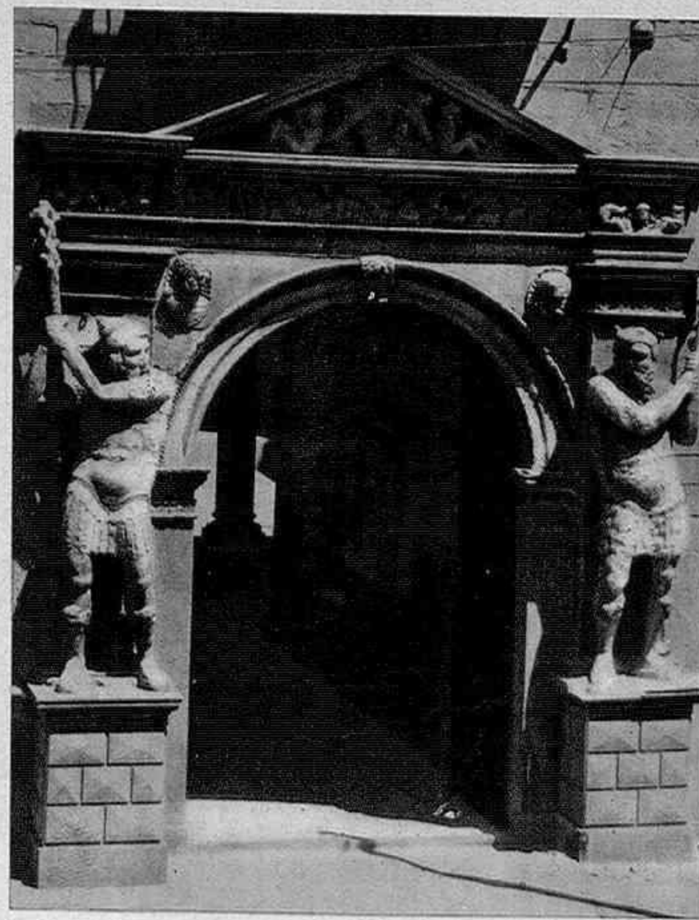
Entrada principal del palacio
