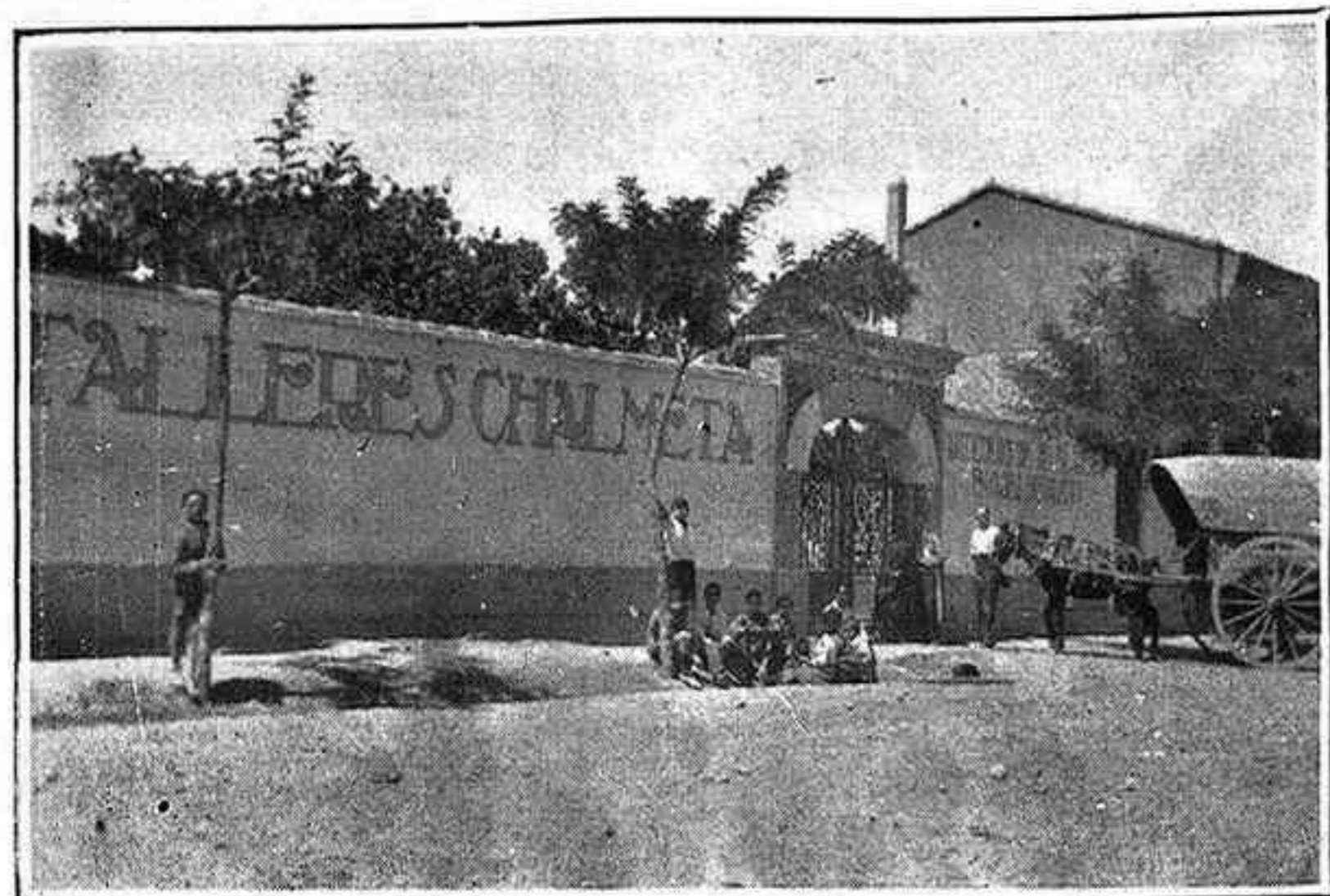
Fachada de los Talleres
