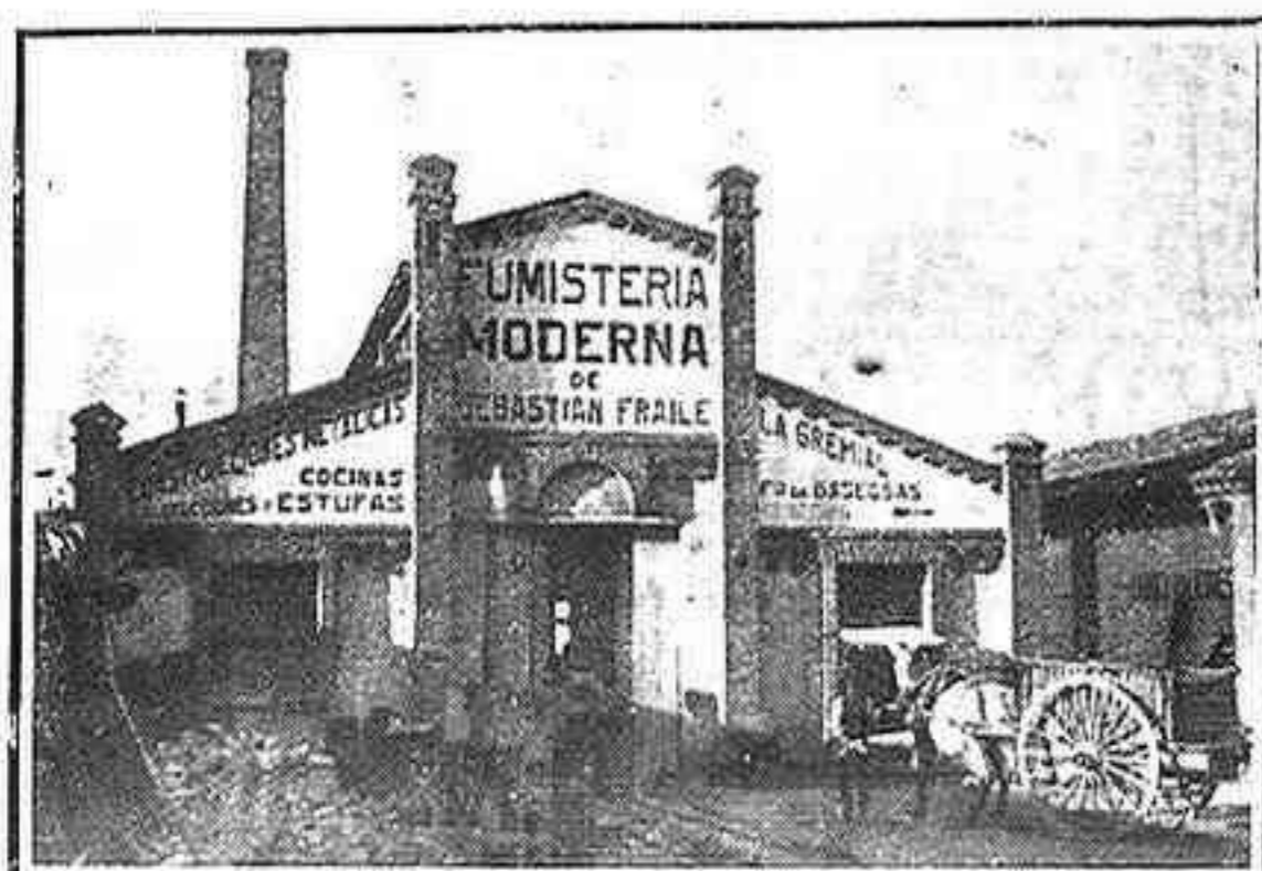
Vista exterior de los Talleres
