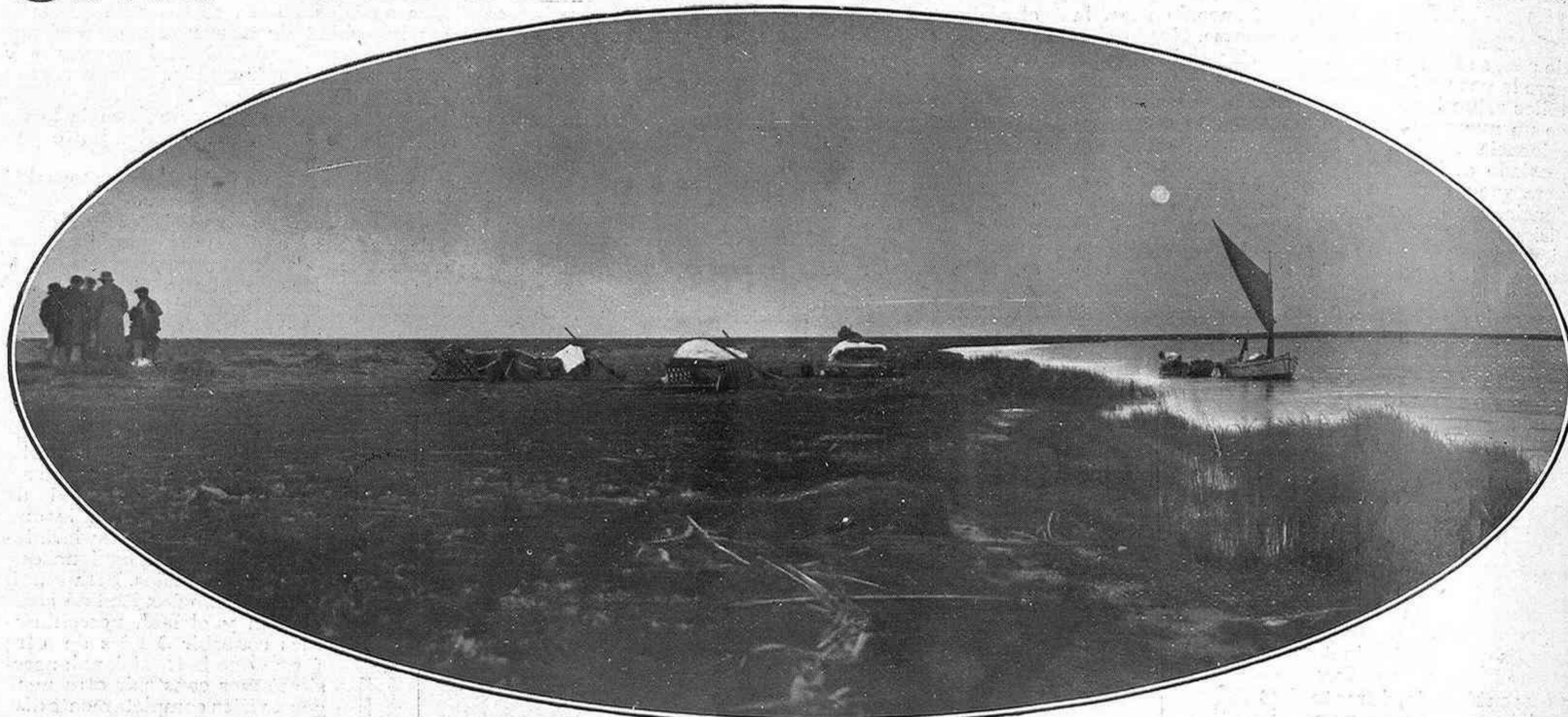
El campamento de los cazadores, al amanecer, en las orillas del Guadalquivir
