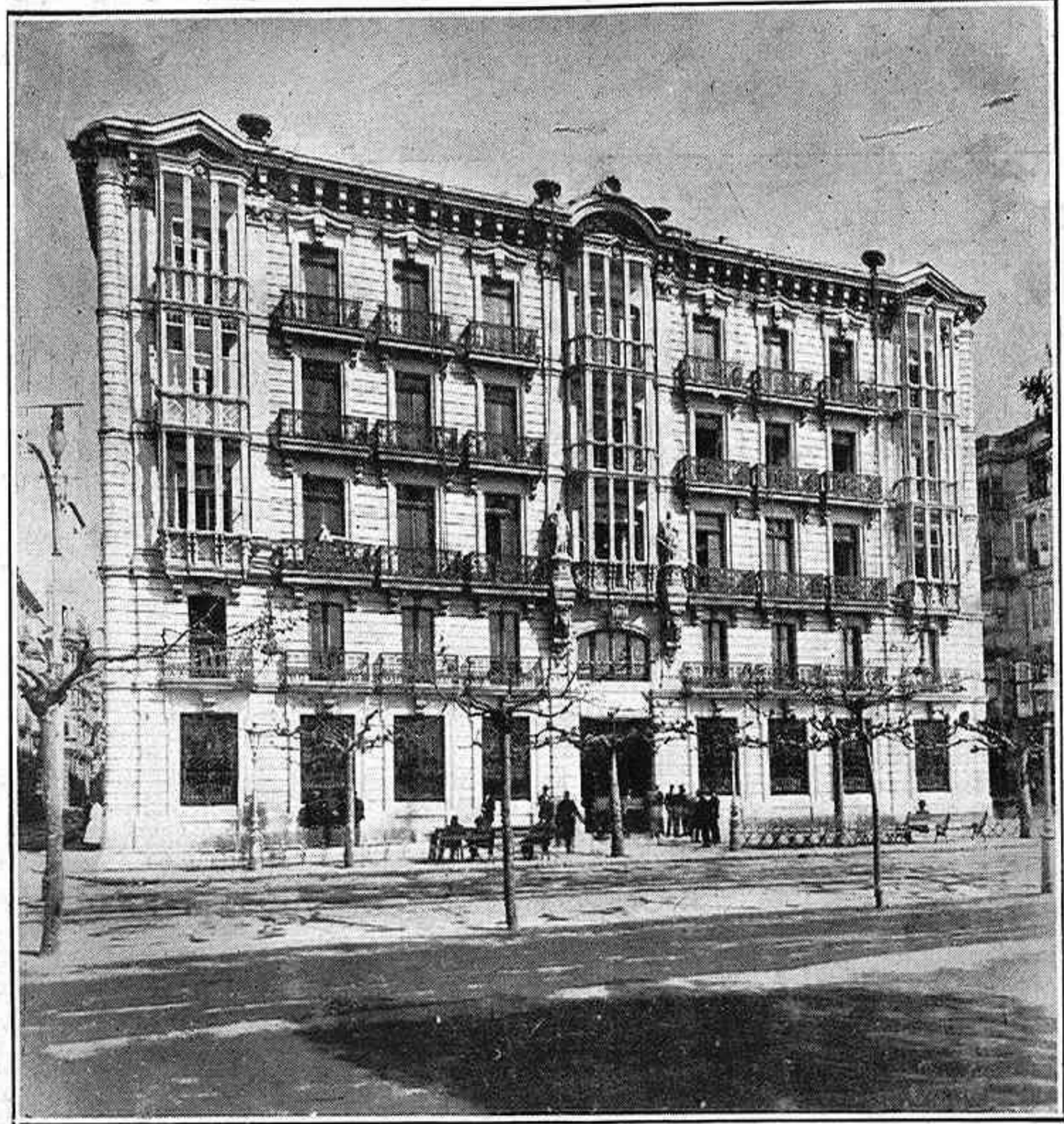
Fachada principal del nuevo y magnífico edificio del Banco de Santander
