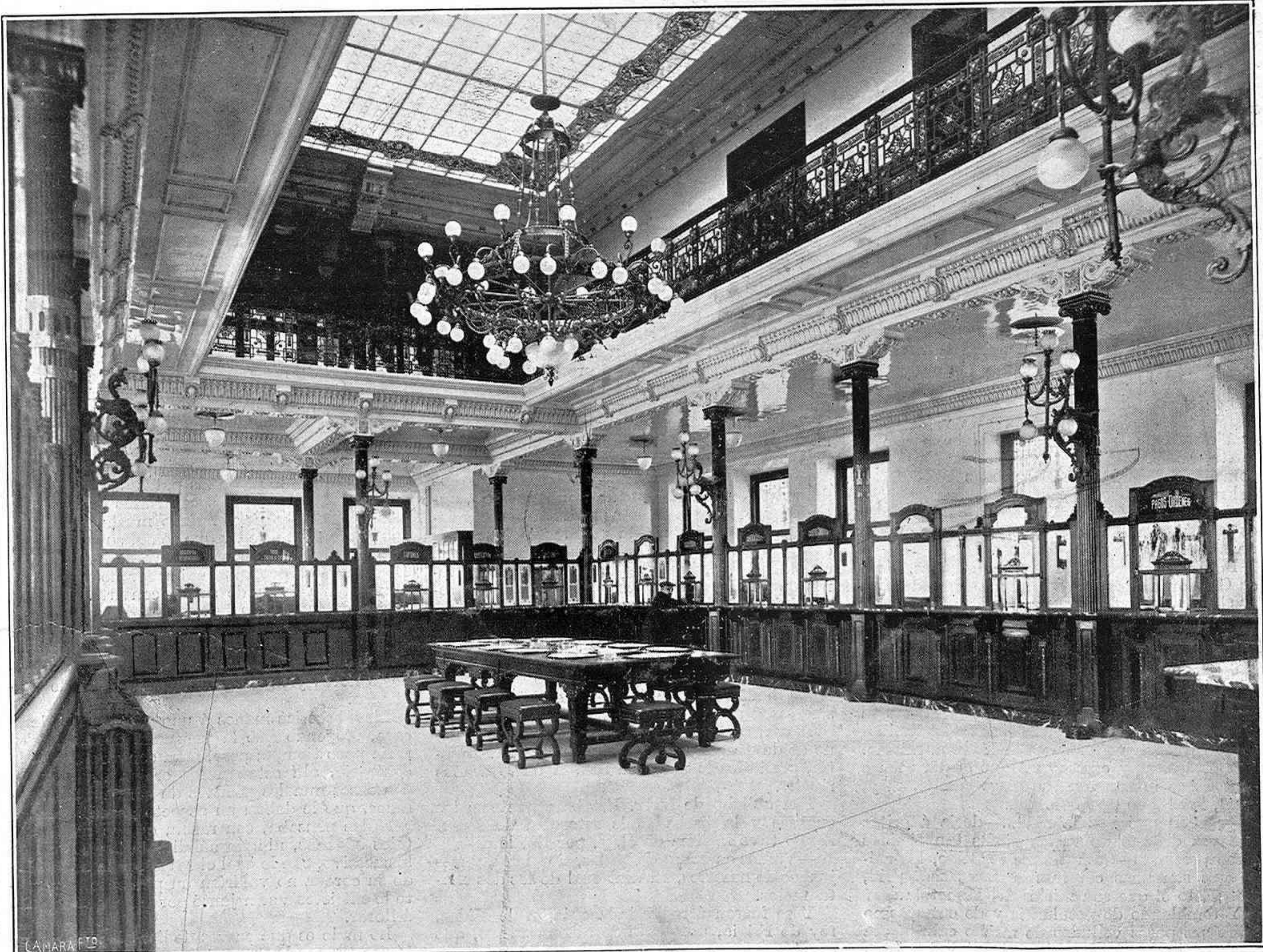
El espléndido «hall» de oficinas del Banco de Santander
