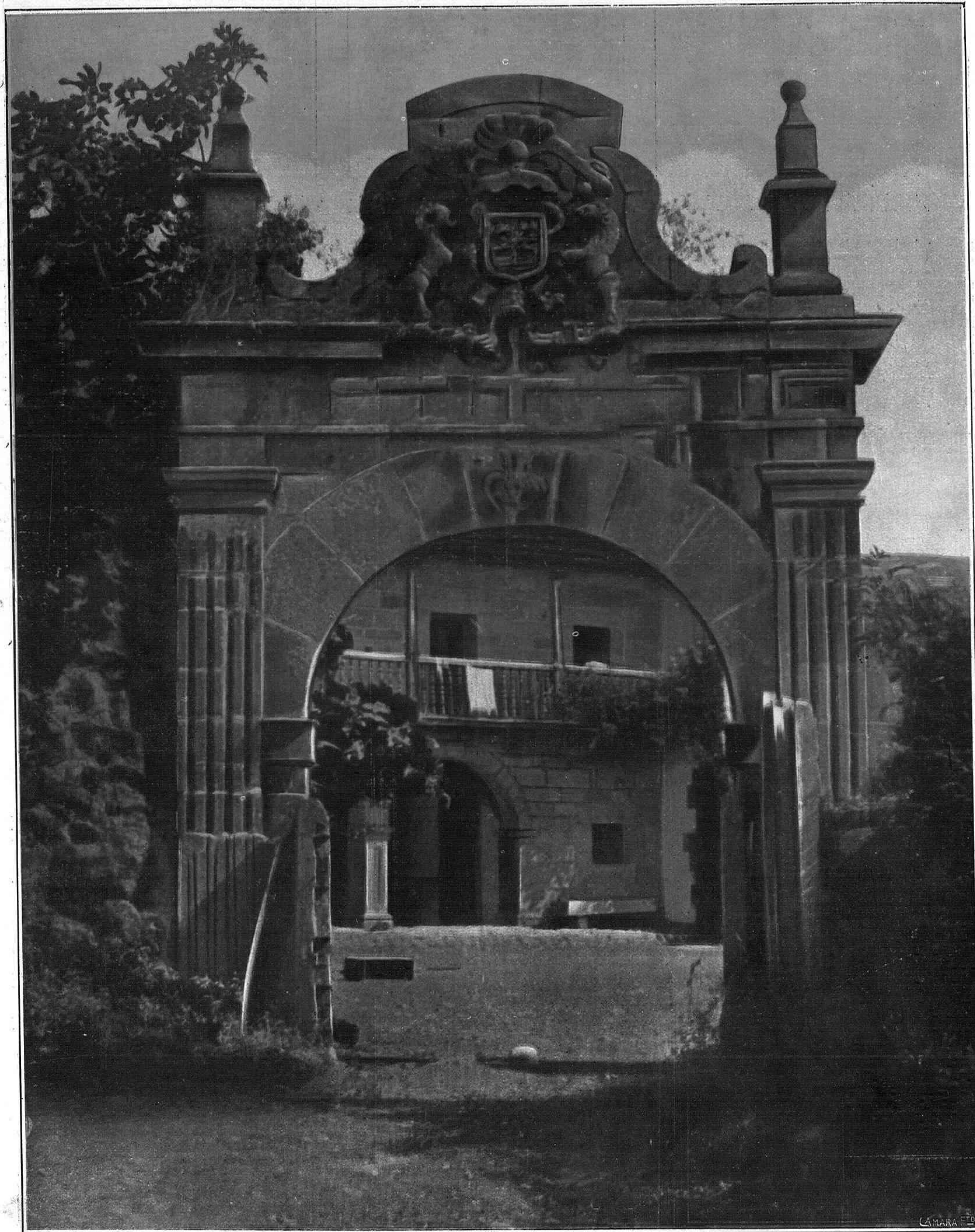
Pórtico de entrada á una casa señorial en un pueblo de Asturias
