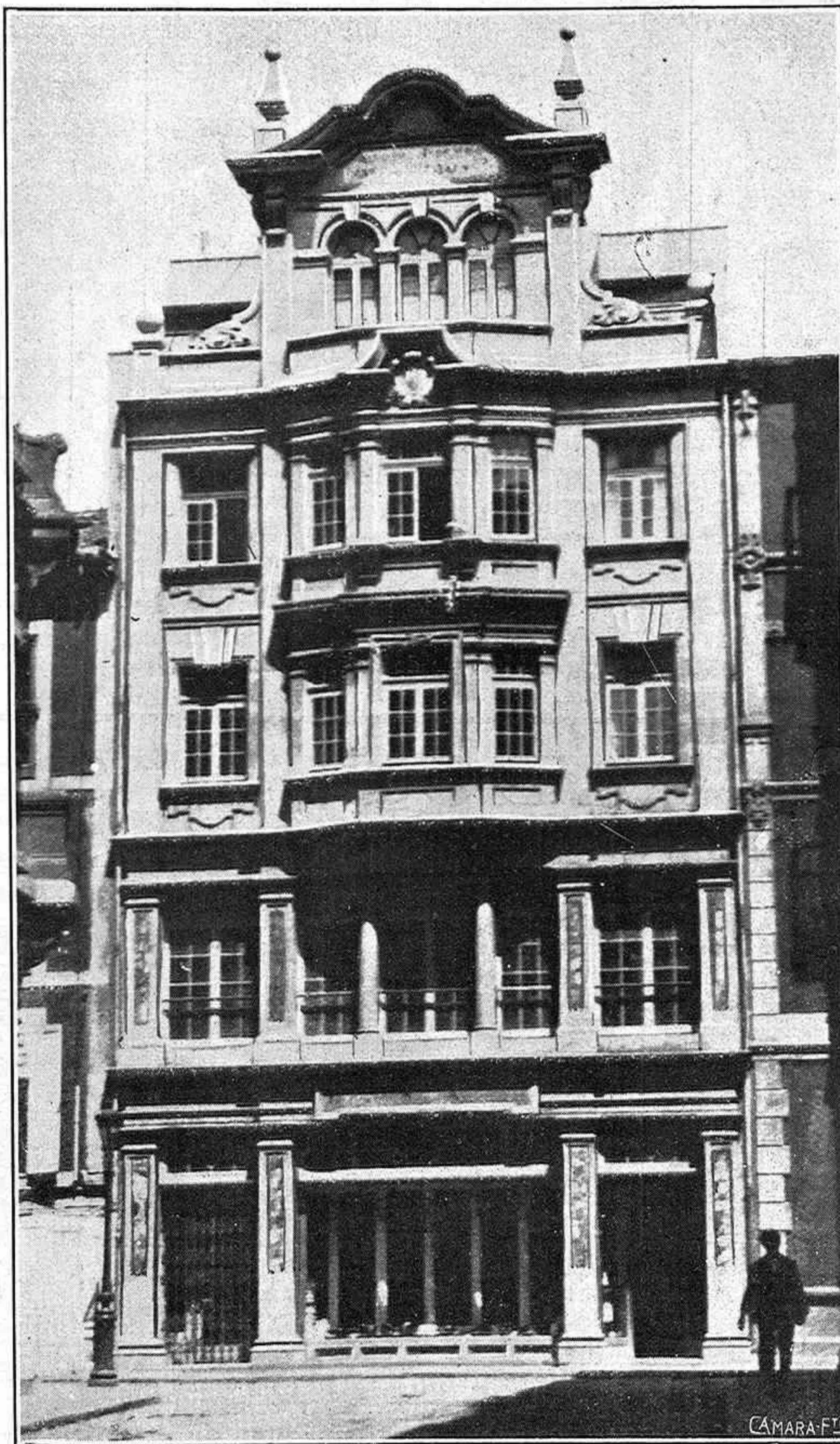
Frente del nuevo y magnífico edificio, propiedad de la «Ferretería Vasco-Asturiana» San Bernardo, 55 y 57. Gijón. Cabrales, 30 y 32
